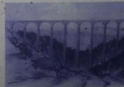
Projekt mit weitgespannten Bogen, Holzkonstruktions gemauerten Pfeilern
