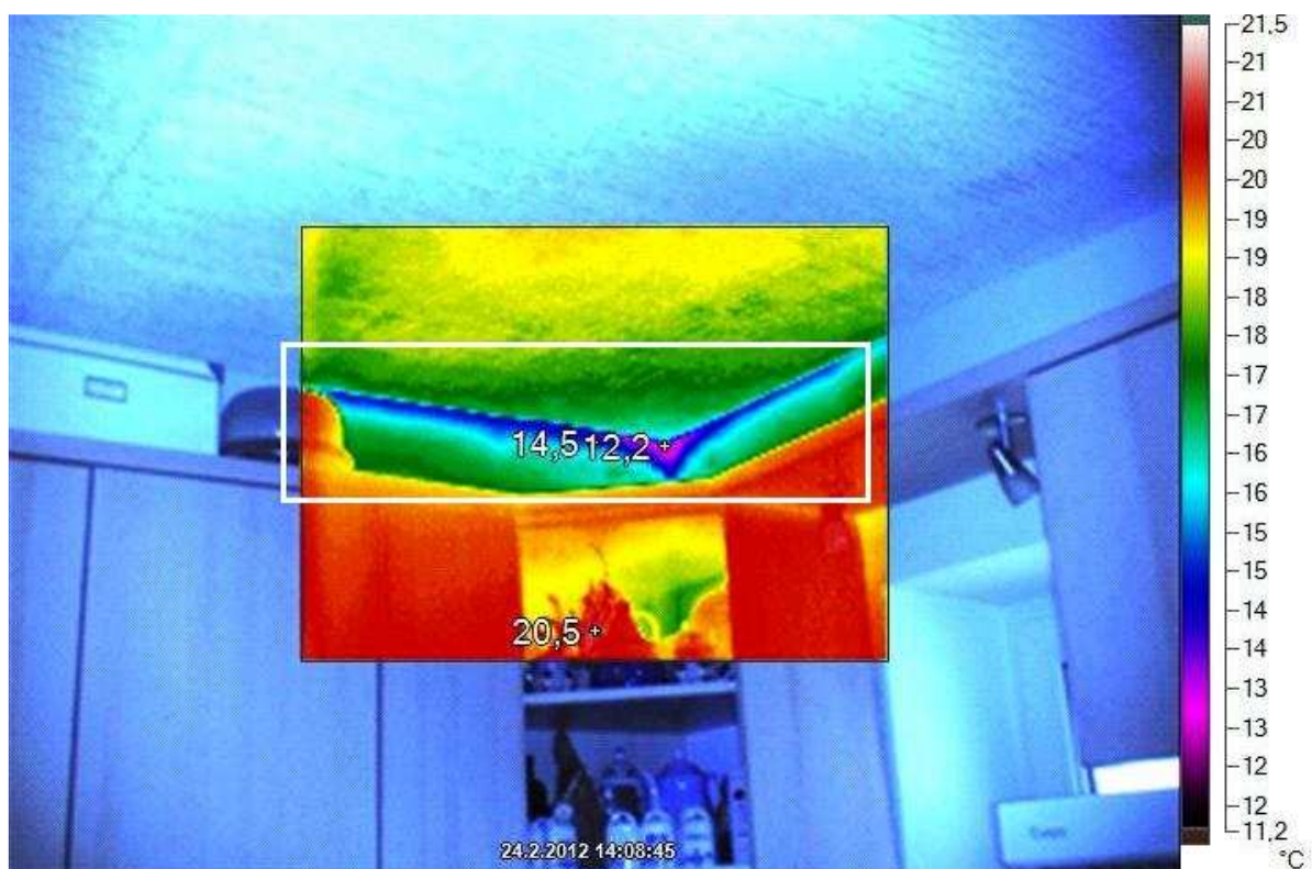
Obr. 5 Ukázka tepelného mostu (v bílém obdélníku)
