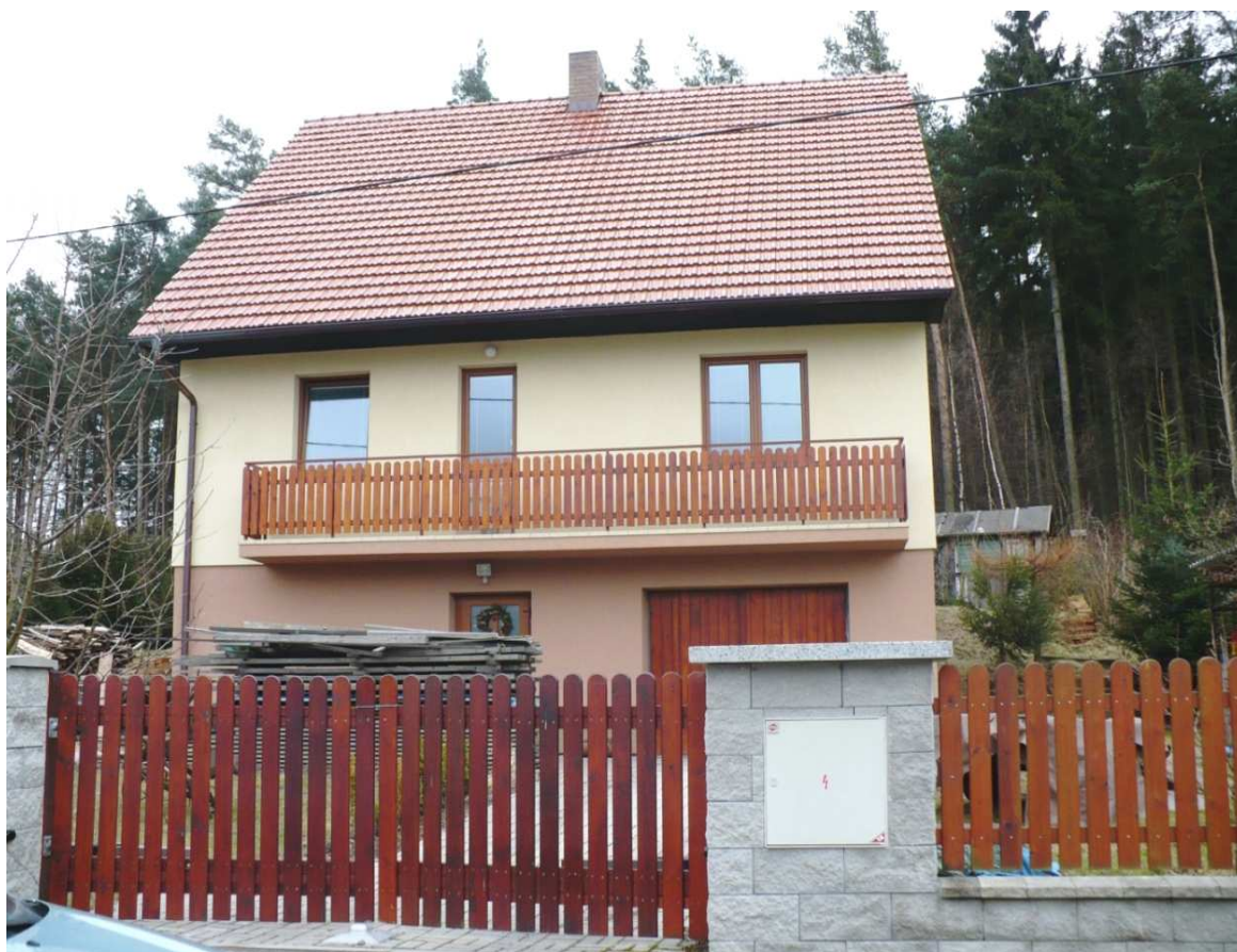
Obr. 1 Pohled na měřený objekt
