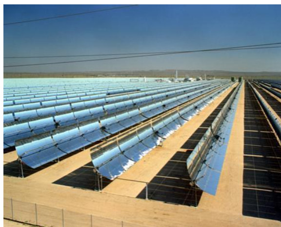
Obr. 1.11 Zrcadlový koncentrátor s parabolickým zrcadlem [7]
