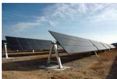
Obr. 1.2 Jednoosý horizontální tracker [7]
