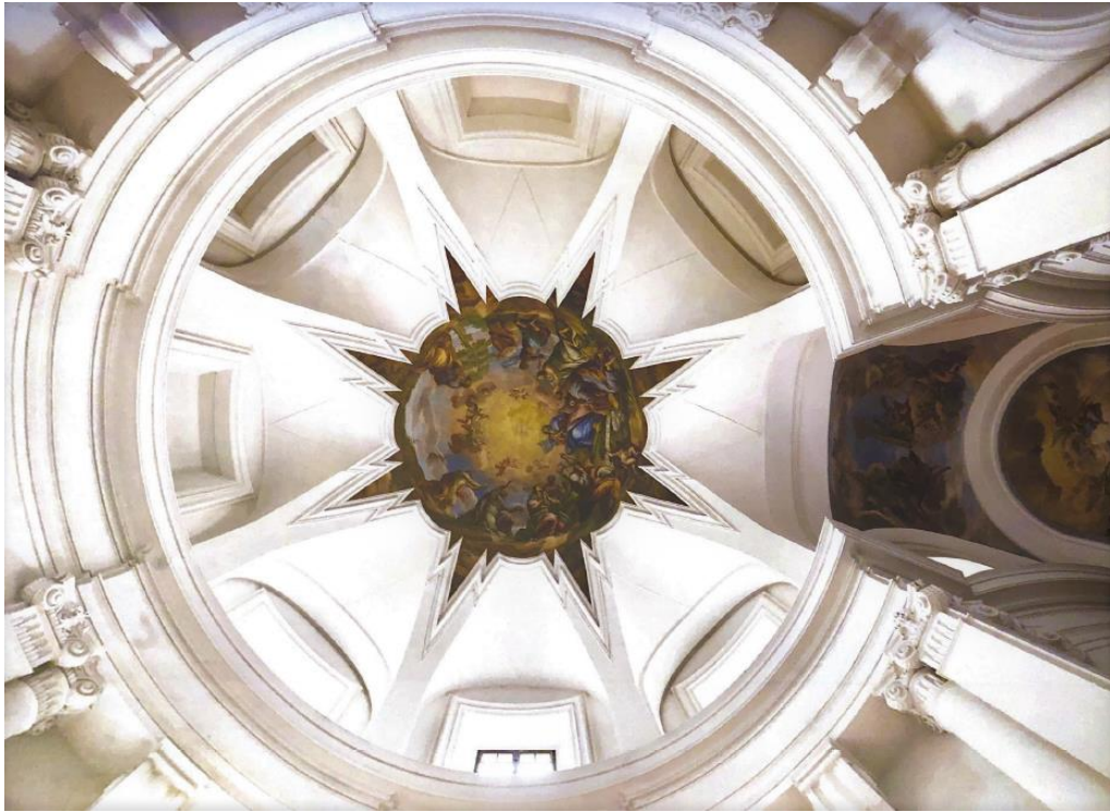
Obrázek 7 - pohled do kupole kaple sv. Bernarda, klášter Plasy
