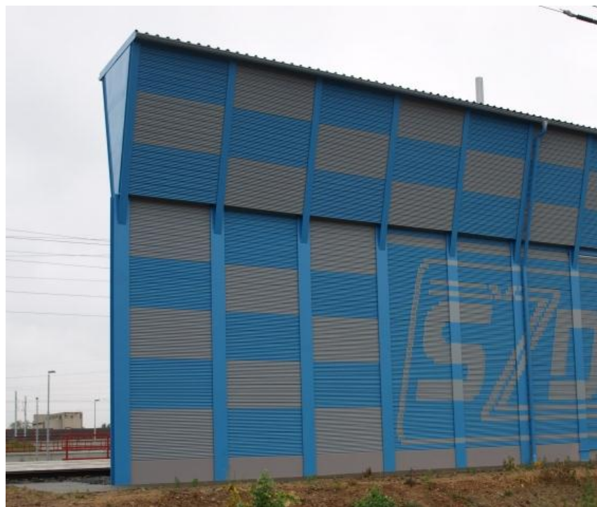
Obr. 4.4 Protihluková stěna s absorbérem. Převzato z [35]
