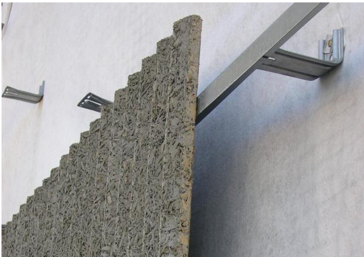
Obr. 4.7 Systém Velox, distanční podložka. Převzato z [45]
