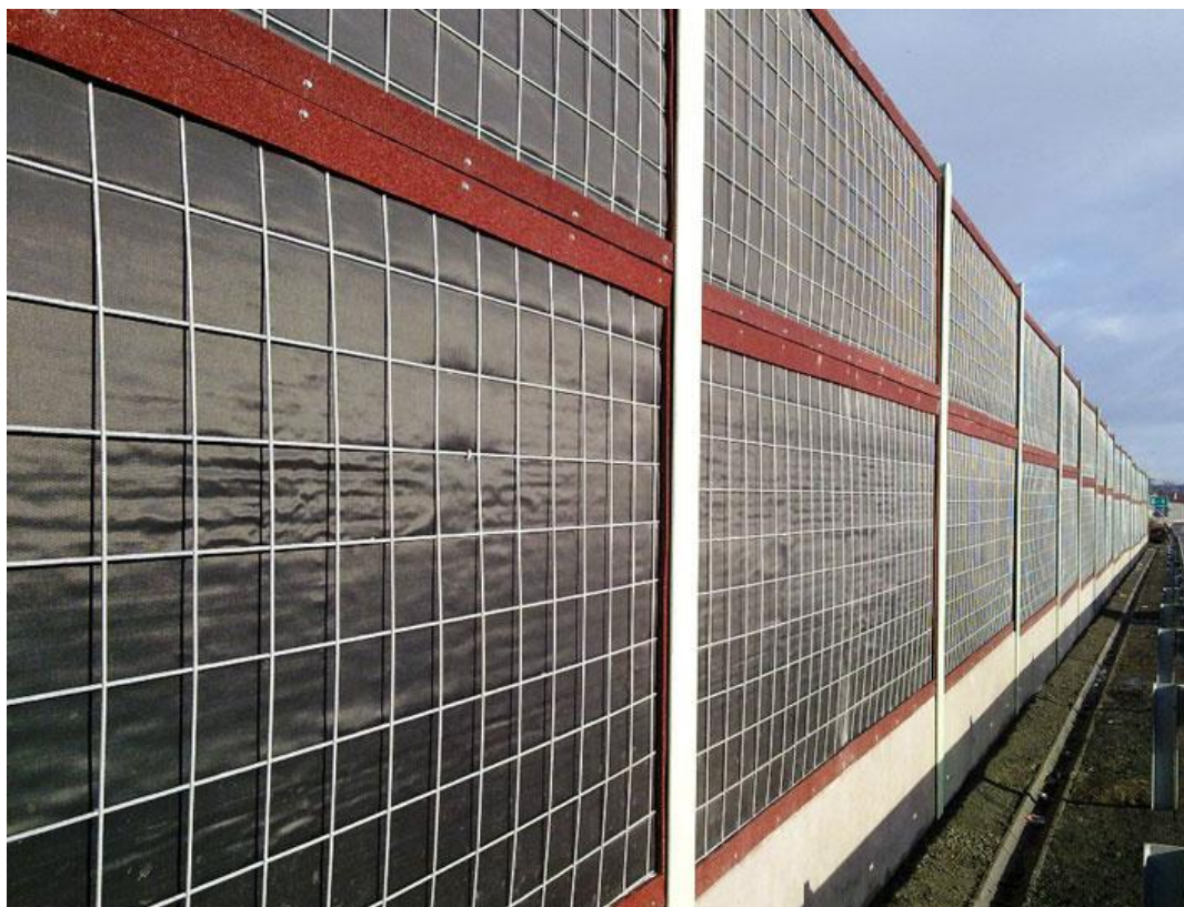
Obr. 4.8 Sklovláknobetonová stěna. Převzato z [47]
