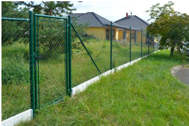
Obrázek 9: Výsledek montáže čtyřhranného pletiva
