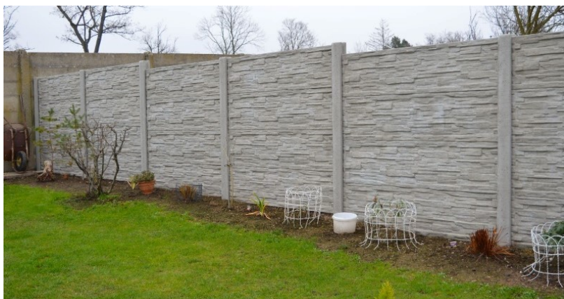
Obrázek 12: Výsledek montáže betonového břidlicového plotu
