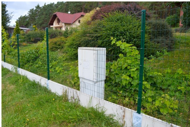
Obrázek 10: Výsledek montáže svařovaného pletiva Hortaplast
