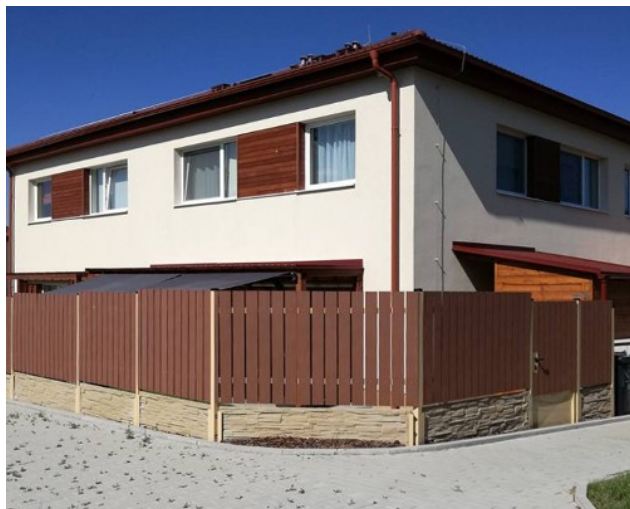
Obrázek 13: Výsledek montáže WPC plotovek
