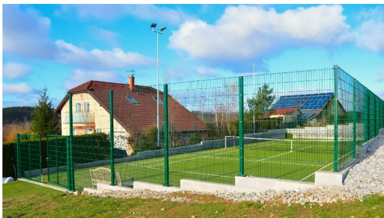
Obrázek 11: Výsledek montáže plotových 2D panelů
