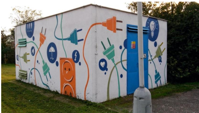
Obrázek č. 31: Malba fasády trafostanice v Praze 8
