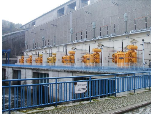
Obr. 22 Vodní elektrárna Orlík
