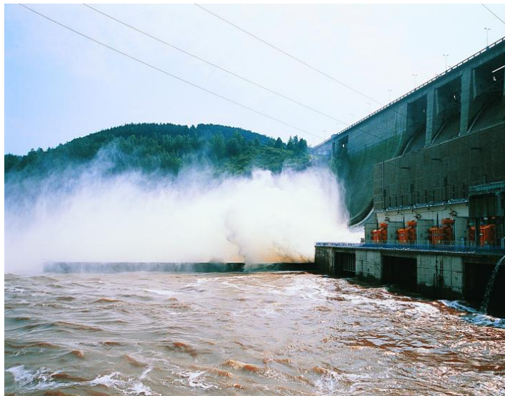
Obr. 1 Povodně v roce 2002 na vodní elektrárně Orlík [11]
