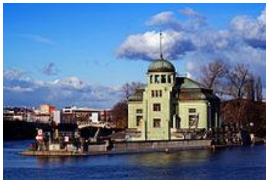
Obr. 19 Pohled na vodní elektrárnu na pražské Štvanici [71]
