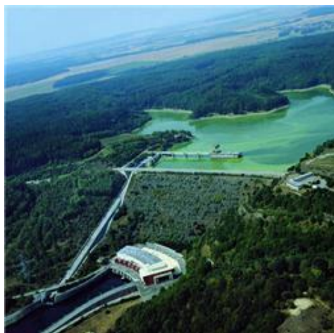
Obr. 21 Pohled na vodní elektrárnu Dalešice [5]
