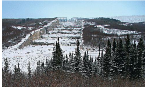
Obr. 35 Přepadový kanál "Spielway" nad podzemní elektrárnou Roberta Bourassa [65]
