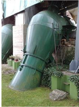
Obr. 10 Savka přepadové turbíny [58]
