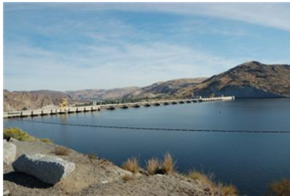
Obr. 32 Vodní elektrárna Grand Coulee [8]
