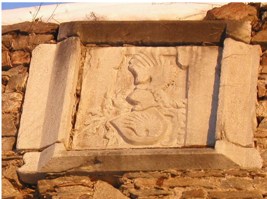
Foto 18: Erb rodu Kaplířů ze Sulevic nad vstupem do Haselburku.
