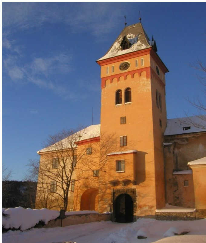
Foto 16: Vstupní věž do Horního zámku, pod kterou býval hradní příkop. Zdroj: vlastní archiv Ing. Antonín Dvořák, kastelán zámku ve Vimperku
