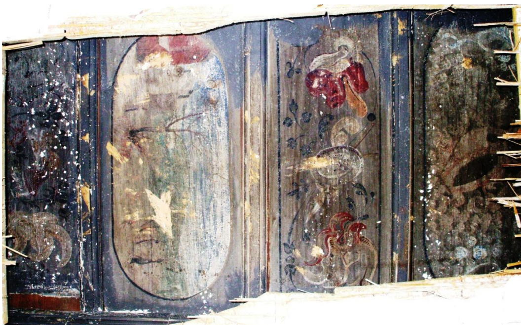
Foto 22: Stropní podhled v severním křídle Horního zámku.
