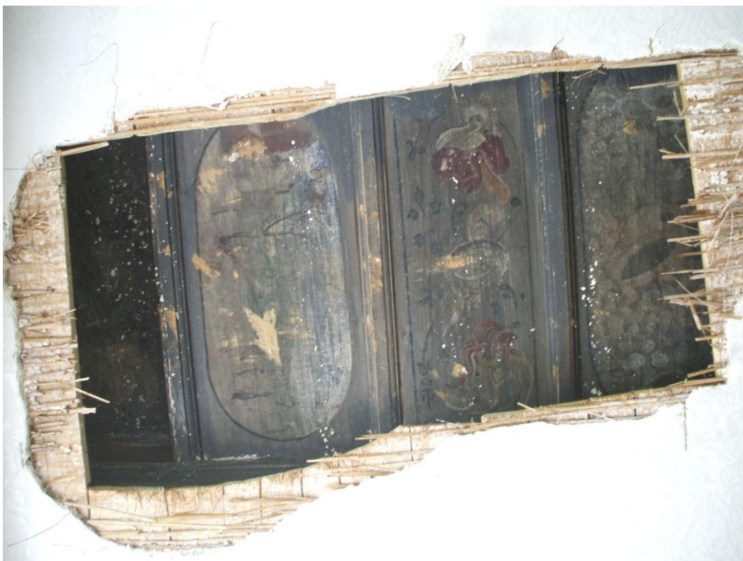
Foto 21: Nalezené renesanční podhledy v části severního křídla v Horním zámku. Dle dendrochronologického průzkumu jsou tyto stropy starší než stropy nalézající se v jižním křídle Dolního zámku.
