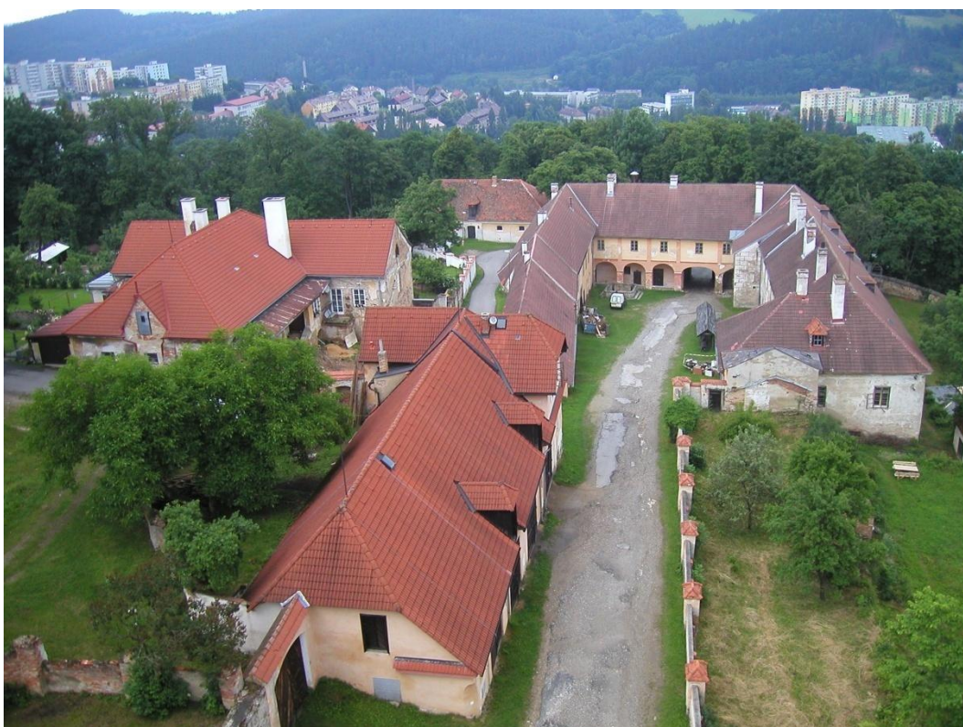
Foto 8: Pohled ze vstupní věže do nádvoří Horního zámku. V pravé části snímku se nalézá původní renesanční budova se zachovalými dřevěnými a malovanými stopy. V levé části snímku se nachází severní křídlo, které je napadeno dřevomorkou. Zdroj: vlastní archiv Zdroj: vlastní archiv Ing. Antonín Dvořák, kastelán zámku ve Vimperku
