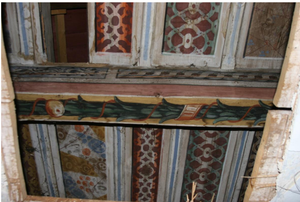
Foto 19: Ukázka původního renesančního dřevěného stropu v jižním křídle Dolního zámku. Zdroj: vlastní archiv Ing. Antonín Dvořák, kastelán zámku ve Vimperku
