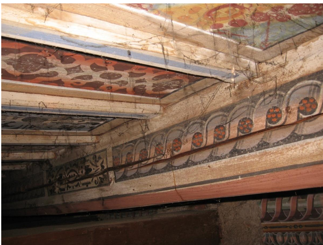
Foto 20: Ukázka původního renesančního dřevěného trámoví stropu. Zdroj: vlastní archiv Ing. Antonín Dvořák, kastelán zámku ve Vimperku
