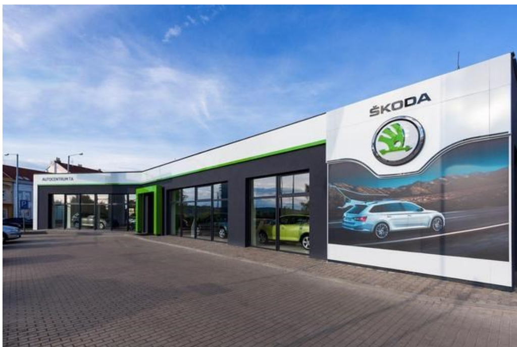
Obr. 10 Exteriér po rekonstrukci
