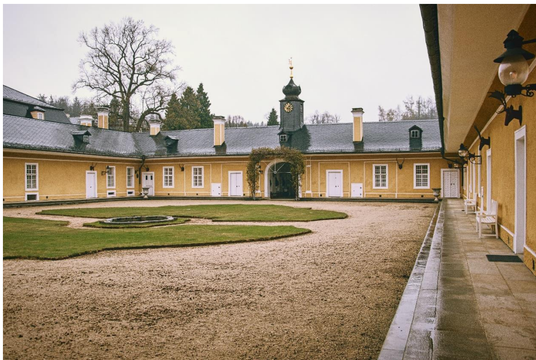
Příloha č. 14: Zámek Kozel – pohled z nádvoří na severní vstupní křídlo 203
