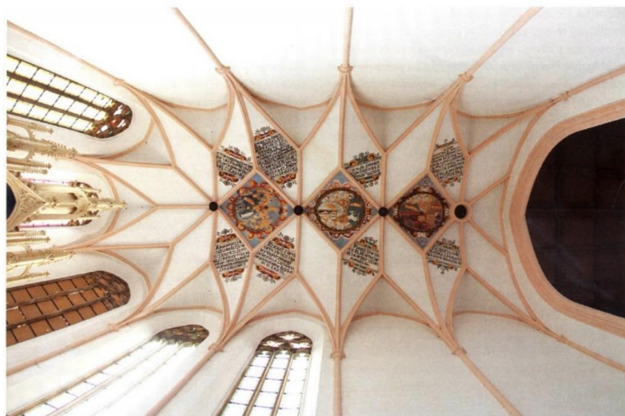
Obr. 13. Klenba hřbitovního kostela sv. Jiljí. Klášter Milevsko 2020, Sakrální stavby , http://www.klaster-milevsko.cz/ , navštíveno 23.04.2022.
