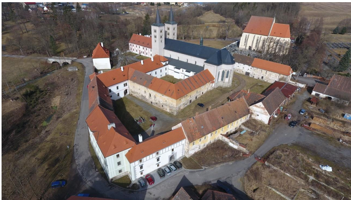
Obr. 19. Areál milevského kláštera včetně kostela sv. Jiljí. Fotografie z roku 2017. Klášter Milevsko 2017, Fotografie z dronu , http://www.klastermilevsko.cz/ , navštíveno 24.04.2022.
