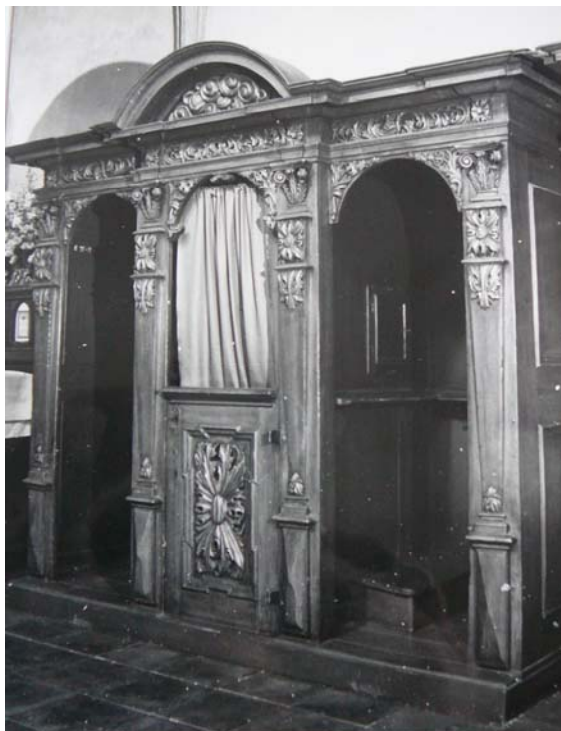
Obr. č. 36 – Pohled na stav zpovědnic v 80. letech 20. století 135
