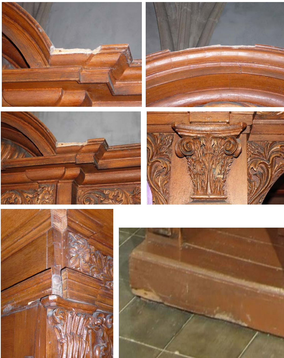
Obr. č. 38 – Detailní pohledy na aktuální stav zpoděnic 137
