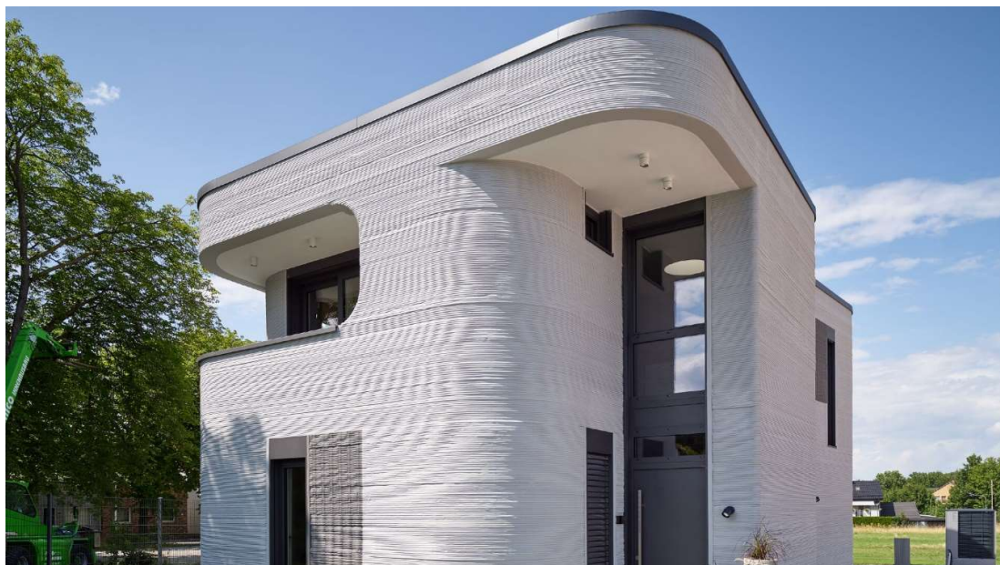
Obr. 1.: První vytištěný dům v Německu firmou Gira (převzato z [1])
