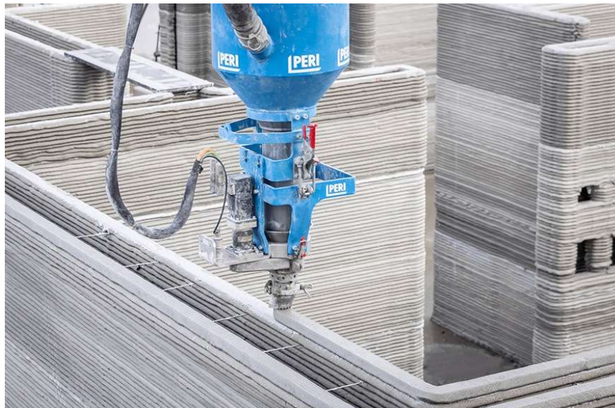
Obr. 14.: Nanášení vrstev betonu během tisku domu (převzato z [19])
