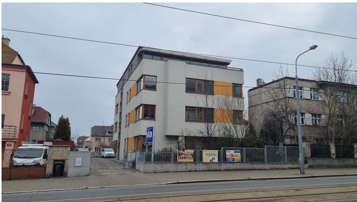
Obr. 4-1: Pohled na budovu ze silnice
