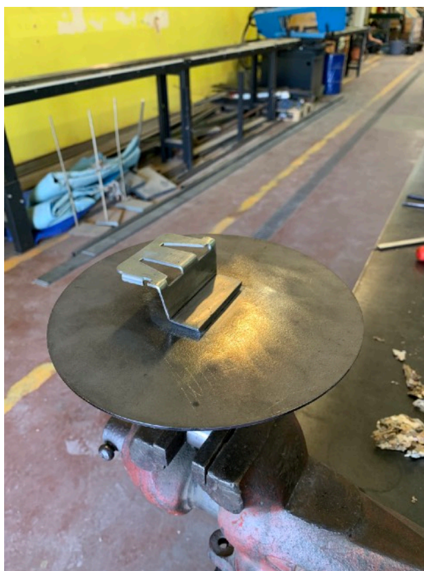
Svaření držáku ke konstrukci
