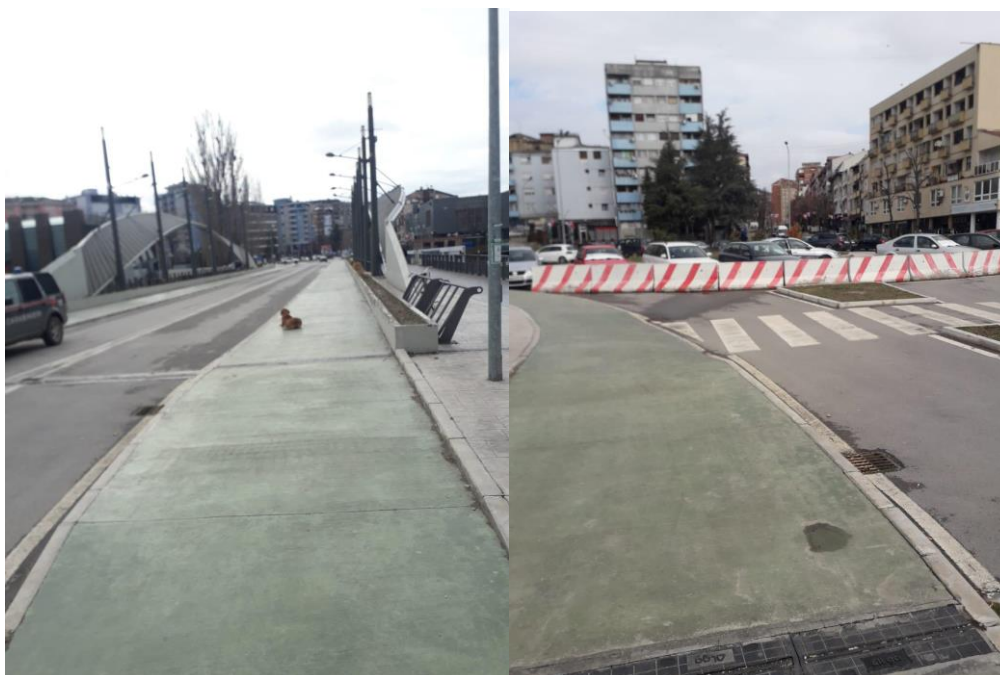
Obrázek 4: Most přes řeku Ibër v Mitrovici; barikáda na srbské straně mostu (4)
