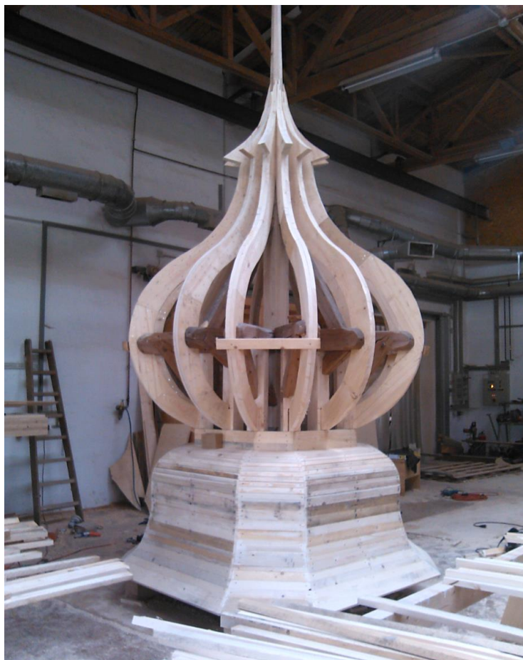
Obrázek 5-2: Dřevěná konstrukce špičky kostela [23]
