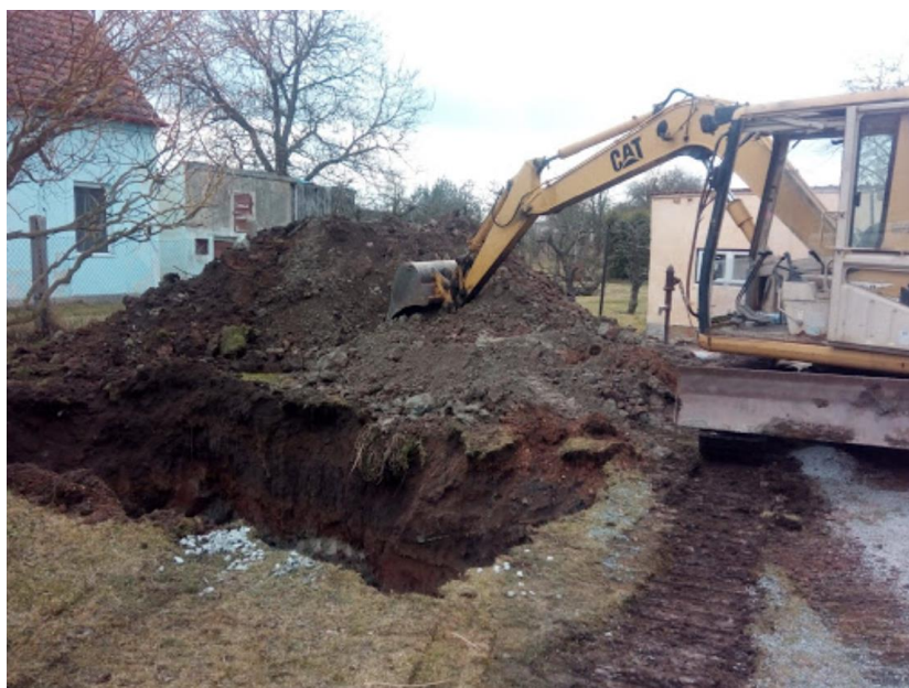
Obrázek 5-8: Zemní práce, Přehýšov [23]
