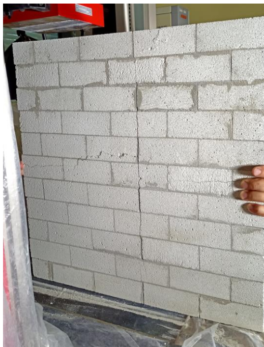
Obr. 70: Porušení stěny N 72 – pohled na rub stěny
