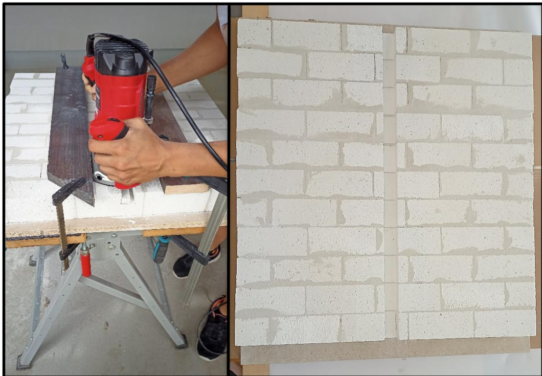
Obr. 64: Frézování svislé drážky vzorku stěny N_{21} s hloubkou a šířkou drážky 26mm Vodorovné drážky byly provedeny v polovině výšky stěny, což znamenalo frézování středem šesté řady cihliček. Po každém drážkování proběhlo kontrolní měření hloubky a šířky drážky šuplerou.
