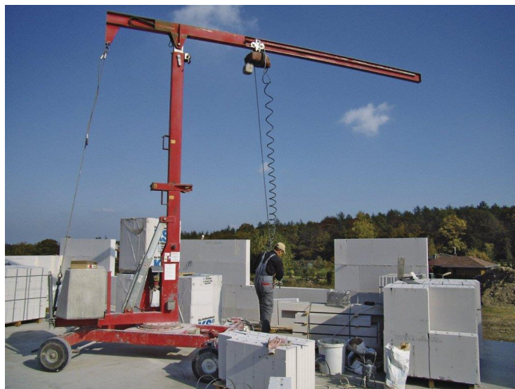
Obr. 31: Průběh jeřábové výstavby z vápenopískových bloků [65]
