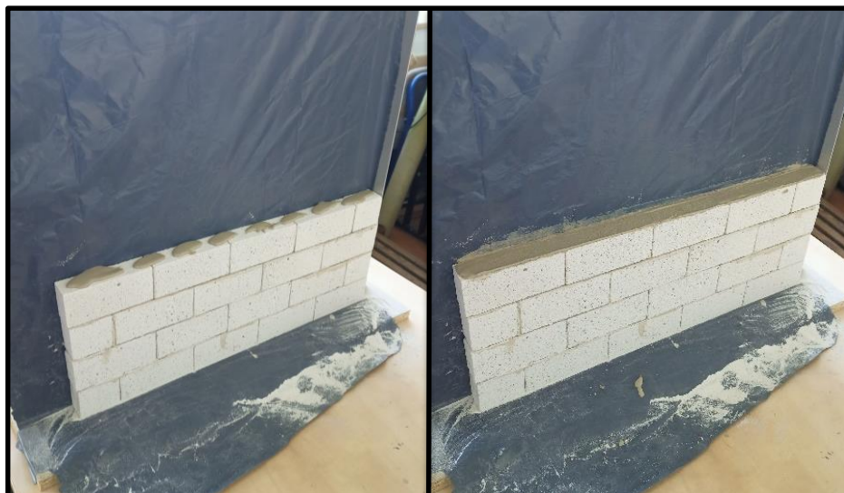
Obr. 59: Celoplošné nanášení tenkovrstvé malty Ytong FIX N103
