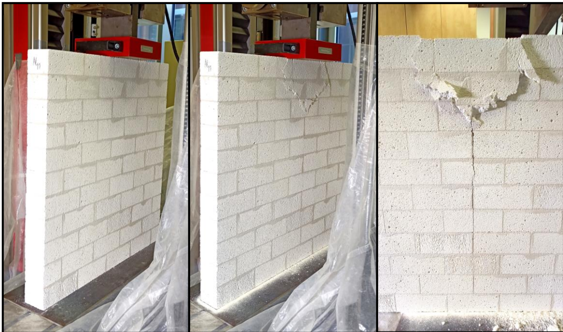
Obr. 68: Průběh zatížení stěny N 11 – porušená oblast soustředěným tlakem
