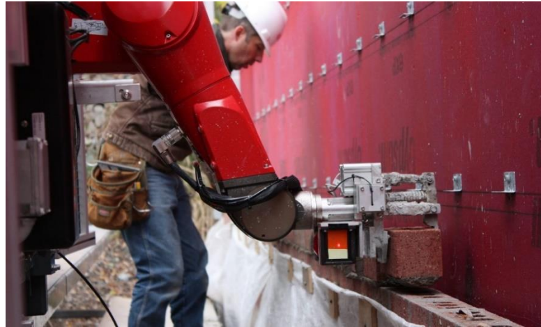
Obr. 40: Poloautomatický zednický robot od společnosti Construction Robotics [82]
