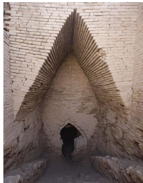
Obr. 8: Klenba přečnělková – zikkurat Ur [13]
