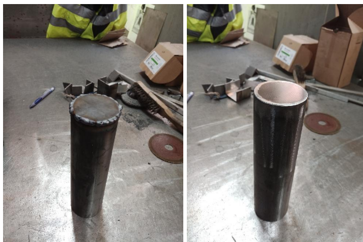
Obr. 41-45, proces sváření ocelových válců (od nařezání tyče po sváření a začištění svárů) (archiv autora)
