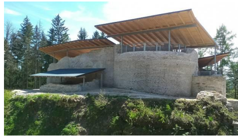
Obr. 32 Opravený hrad Vizmburk
