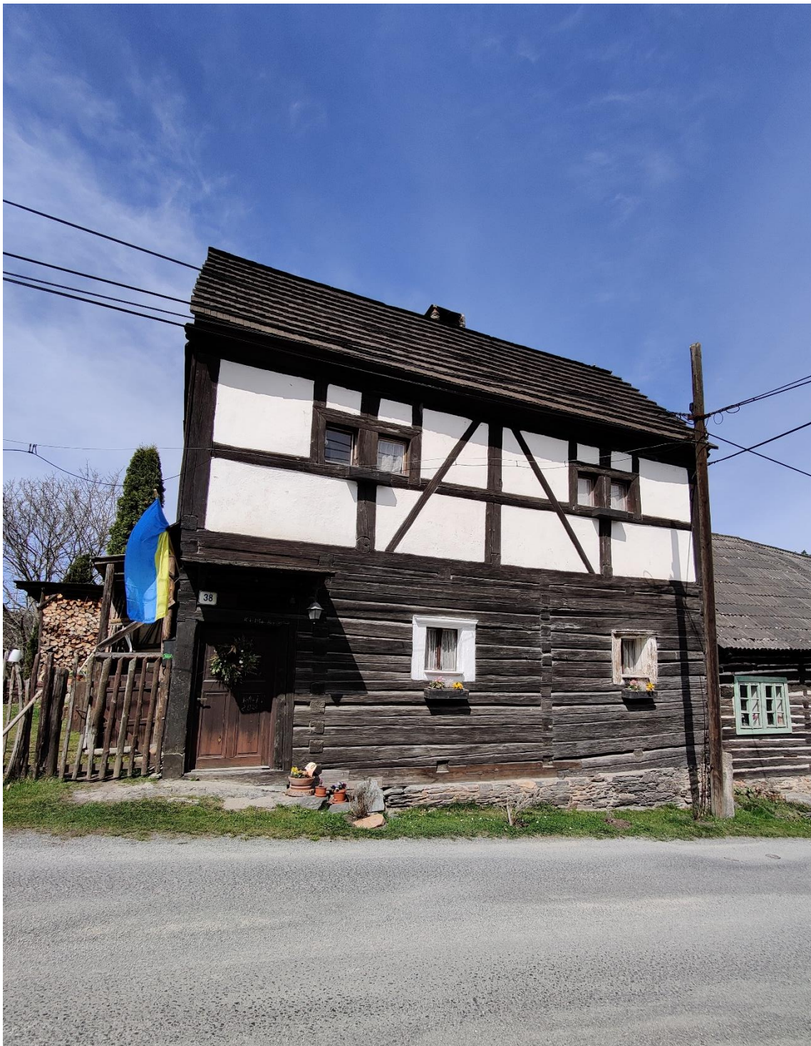
Obrázek 11 - Hrázděný dům v Rabštejně nad Střelou (vedle viditelný dům roubený)
