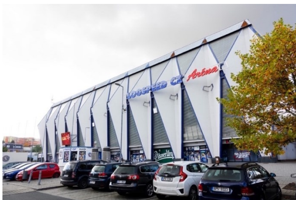
Obrázek 7: Pohled na současný stadion
