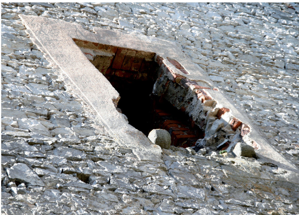
Obr. 6. Portál s dvojicí konzolek a vpádninou pro zvoditý most ve 4. podlaží východní stěny věžového paláce. Foto M. Patrný. – Abb. 6. Portal mit dem Paar kleinen Konsolen und mit der Einsenkung für die Hebebrücke im 4. Geschoss der Ostmauer des Turmpalastes. Fotografie M. Patrný.
