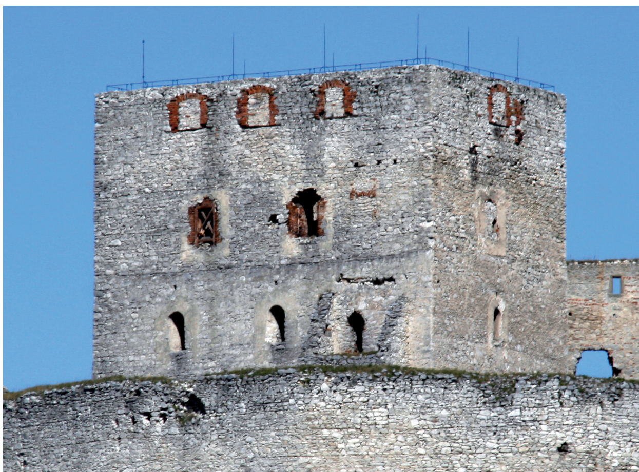
Obr. 1. Pohled na západní a jižní průčelí věžového paláce. Na snímku je velmi dobře patrna horizontální spára mezi 3. a 4. podlažím – stavební fáze mezi 50. a 80. léty 14. století. Foto M. Patrný. – Abb.1. Blick auf die westliche und südliche Stirnseite des Turmpalastes. Auf der Fotografie ist die horizontale Spalte zwischen 3. und 4. Geschoss gut sichtbar- die Bauphase zwischen 50. und 80. Jahren des 14. Jahrhunderts. Fotografie M. Patrný.
