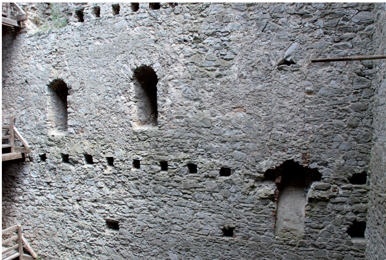
Obr. 10. Interiér východní zdi věžového paláce v úrovni 3. podlaží, s trojicí zazděných půlkruhových oken. Okno vpravo, zazdžené až po vnitřní líc, bylo při pozdně gotické přestavbě změněno na větrací sopouch pro prostory ve 2. podlaží. Foto M. Patrný. – Abb. 10. Das Interieur der Ostmauer des Palastes auf der Ebene des 3. Geschosses, mit den drei zugemauerten halbrundigen Fenstern. Das Fenster fechte, zugemauert bis der inneren Vorderseite war bei der spätgotischen Umbau verändert auf der Abgasfuchs für die Räumlichkeiten im 2. Geschoss. Fotografie M. Patrný.
