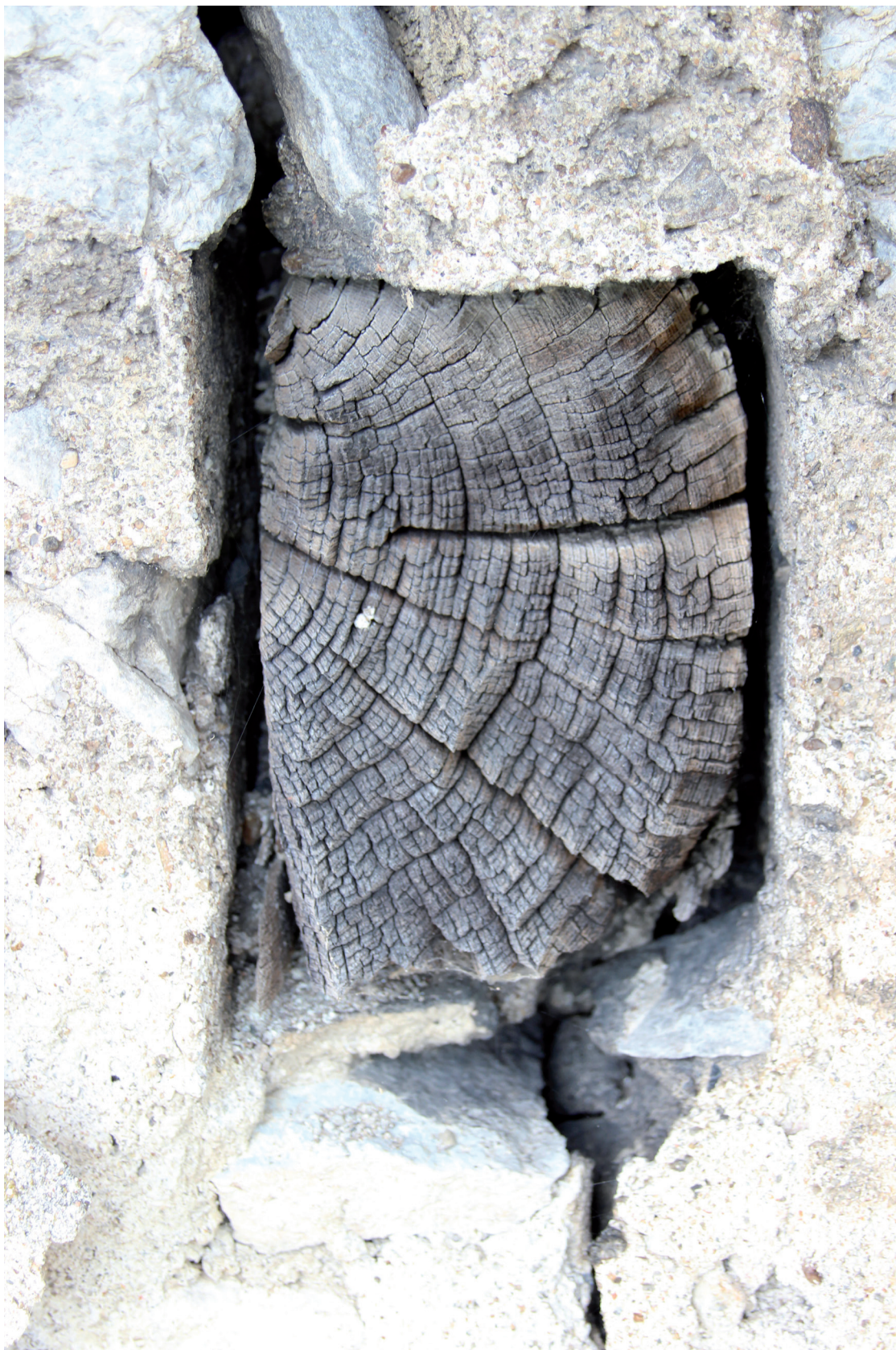
Obr. 9. Detail dubového trámku nad záklenkem okna ve 3. podlaží jižní stěny věžového paláce. Dendrochronologicky datováno 1351–52. Foto M. Patrný. – Abb. 9. Detail des kleinen Eichbalken über dem Fensterbogen in dem Mauerwerk des Südmauer des Turmaplastes. Dendrochronologisch datiert in den Jahren 1351-52. Fotografie M. Patrný.
