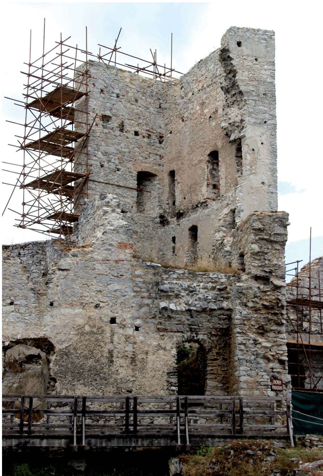
Obr. 12. Věž při někdejší 4., tzv. Žižkově bráně, pohled od východu. V popředí torzo západní zdi průjezdu zbořené brány, s výběhem záklenku a vstupem do strážnice. Foto M. Patrný. – Abb. 12. Der Turm bei dem ehemaligen Žižka-Tor, Blick von Osten. In der Vordergrund der Torso der Westmauer der Durchfahrt des abgerissenen Tores, mit dem Teil des Fensterbogens und mit dem Eingang in die Wachstube. Fotografie M. Patrný.
