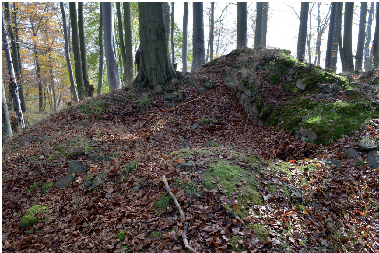
Obr. 16. Nový Žeberk. Pohled na stavbu I/2 od SSV. Foto M. Sýkora. – Abb. 16. Nový Žeberk. Blick auf Gebäude I/2 aus nordnordöstlicher Richtung. Foto M. Sýkora.
