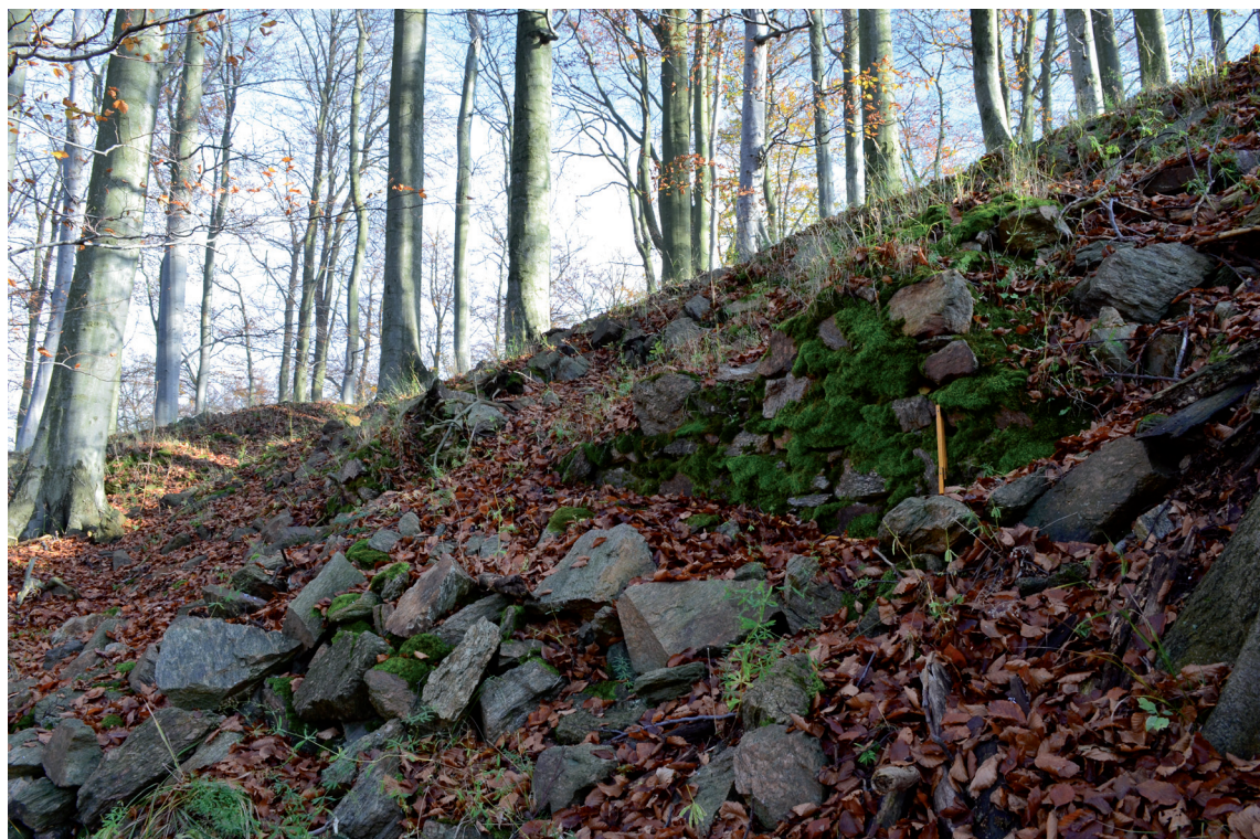
Obr. 23. Nový Žeberk. Pohled na relikty severního úseku parkánové hradby oddílu III od SZ. Foto M. Sýkora. – Abb. 23. Nový Žeberk. Blick auf Relikte des nördlichen Abschnitts der Zwingermauer in Teil III aus nordwestlicher Richtung. Foto M. Sýkora.
