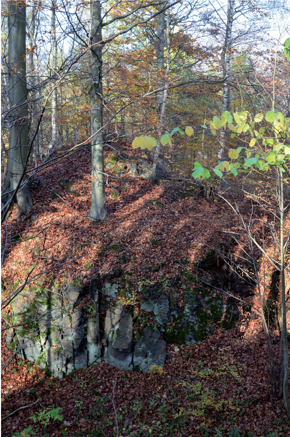
Obr. 30. Nový Žeberk. Pohled na baštu V/1 od J. Foto M. Sýkora. – Abb. 30. Nový Žeberk. Blick auf Bastei V/1 aus südlicher Richtung. Foto M. Sýkora.
