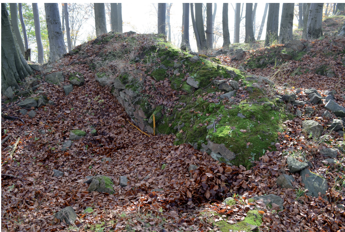
Obr. 15. Nový Žeberk. Východní vnější líc paláce. Foto M. Sýkora. – Abb. 15. Nový Žeberk. Außenseite der östlichen Palasmauer. Foto M. Sýkora.
