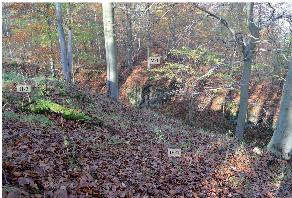
Obr. 21. Nový Žeberk. Pohled na relikty bašt II/3, IV/1 a V/1 od J. Foto M. Sýkora. – Abb. 21. Nový Žeberk. Blick auf die Relikte der Basteien II/3, IV/1 und V/1 aus südlicher Richtung. Foto M. Sýkora.
