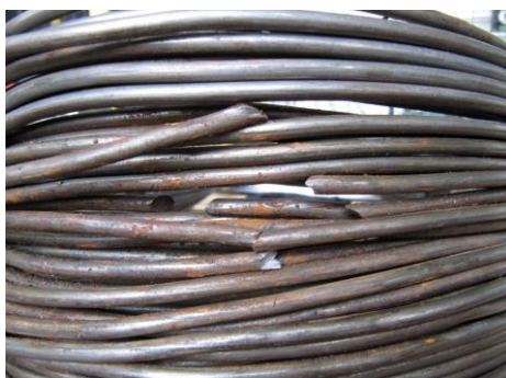
Obr. 3: Pohled na vnitřní část smyčky kabelů – úbytek konzervační vazelíny, korozní napadení a viditelné lomy drátů [7]
