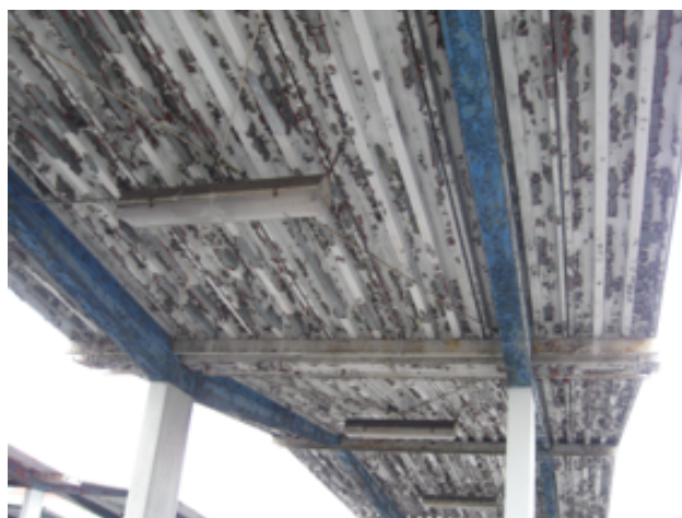
Obrázek 2.3: Zrezavělá konstrukce
