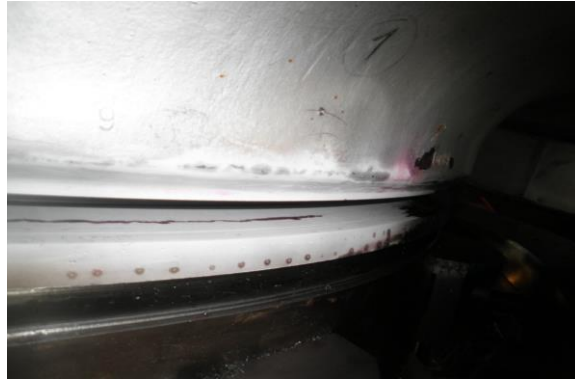
Obr. 2 Pohled na vadu v průběhu jejího řezání a odběru vzorku
