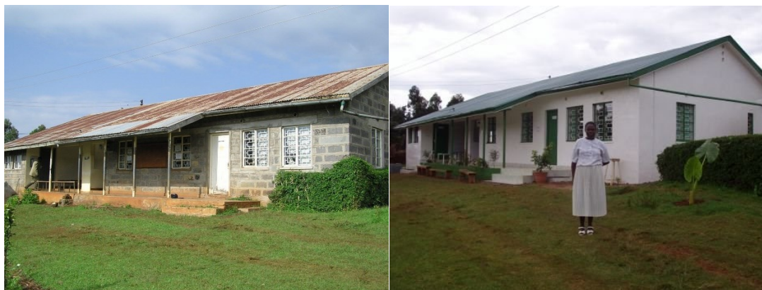
Obr. 5: Budova ambulance před a po rekonstrukci
