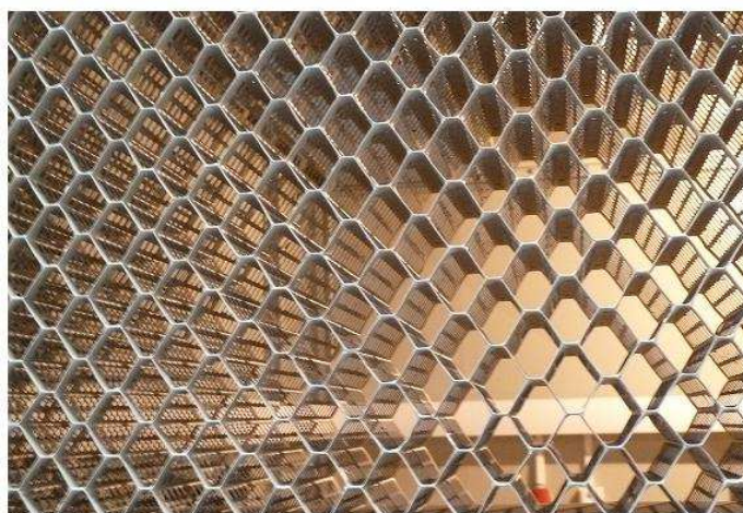
Obr. 3.8: Průhled z vlnodů plechové odstíněné komory
