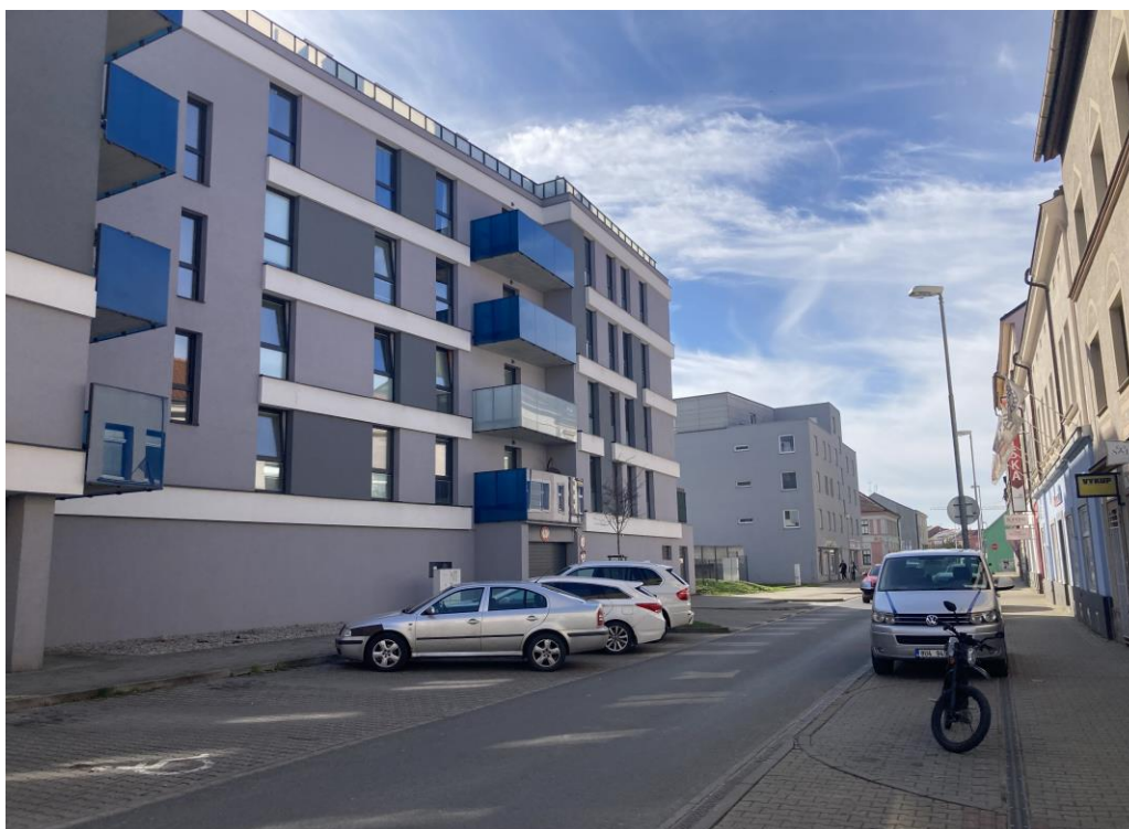
Fotografie č. 21: Nová bytová jednotka v Kollárově ulici. Foto: autor
