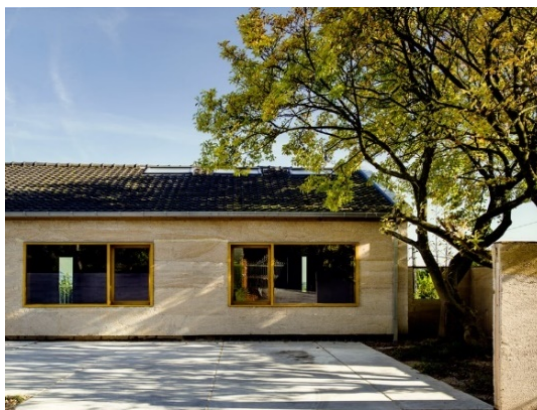
Obrázek 22 - Martens Van Caimere Architecten, Ghent studio, 2014
