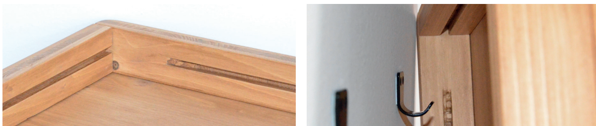
Obr. 29 - Drážky na zavěšení (archiv autora)
