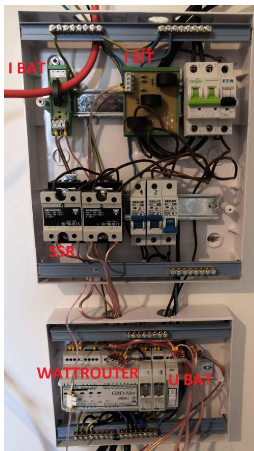
Obr. 14: Umístění zařízení v rozvaděči
