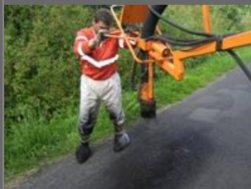
Vysprávký vozovek tryskovou metodou
