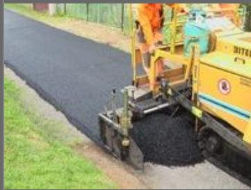
Zhotovení nové povrchové vrstvy místních komunikací
