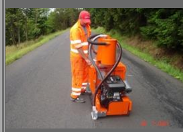
Sanace spár a trhlin
