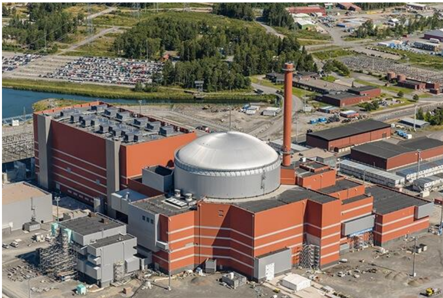
Obr. 1 Jaderná elektrárna Olkiluoto 3 [46]
