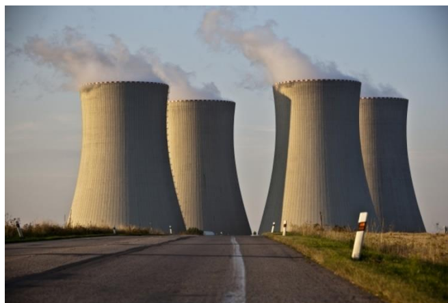
Obr. 4 Chladící věže ETE [48]
