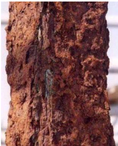
Obr. 3: Objemné korozní produkty na hlavním nosníku kovových plastik Sloupu nejsvětější Trojice v Olomouci Zdroj: (Novák, 2006)
