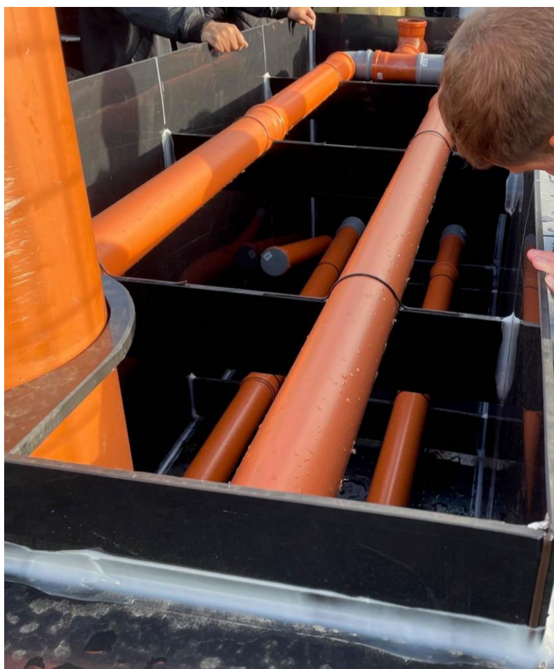
Obrázek 15 - zemní pískový filtr
