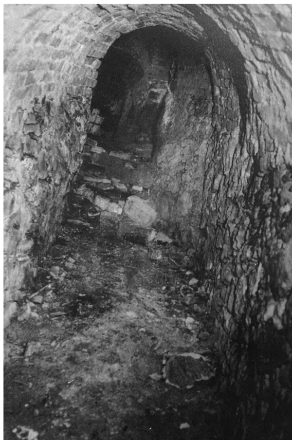
Obr. 8: Podzemní chodba s cihlovou klenbou
