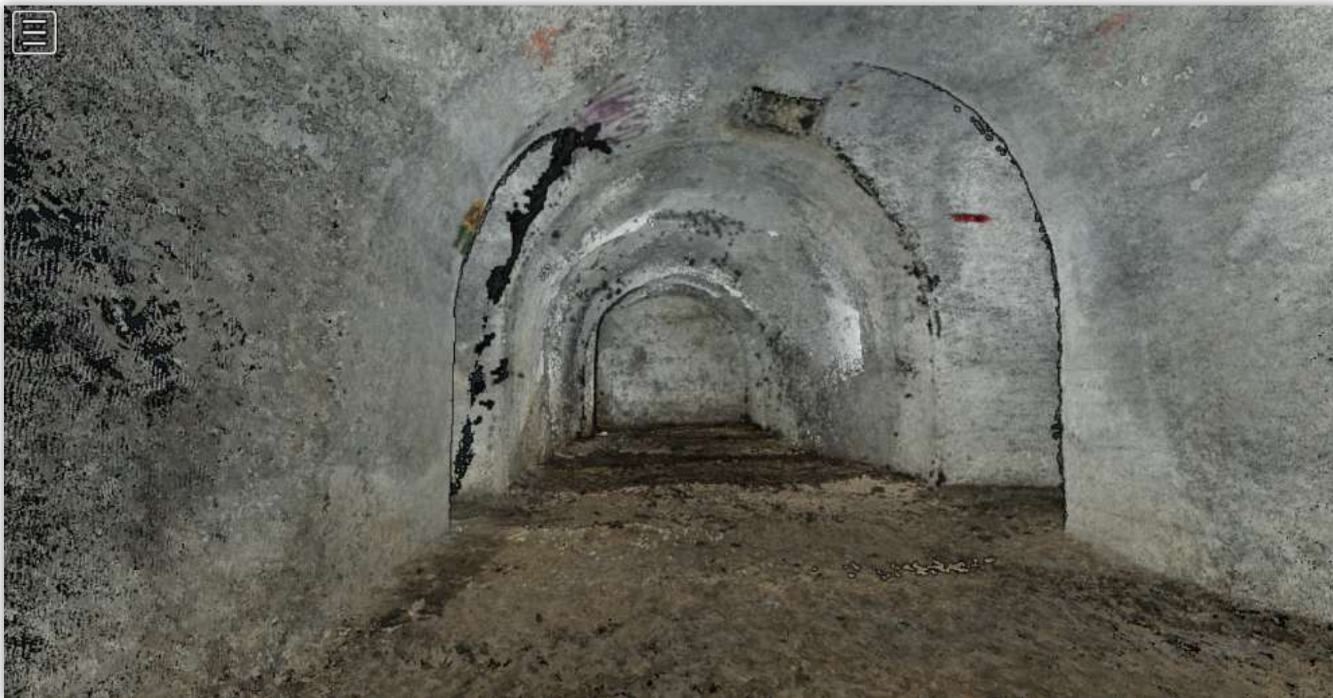
Příloha č. 14: Pohled dovnitř fotogrammetrického mračna bodů
