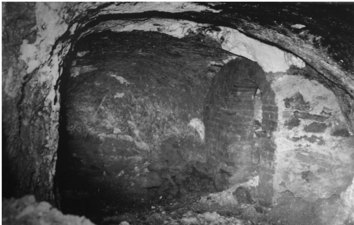
Obr. 9: Podzemní prostor s cihlovou stěnou
