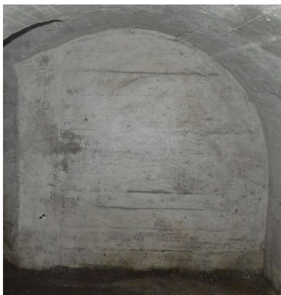
Obr. 4: Zakončení podzemní chodby betonovou příčkou
