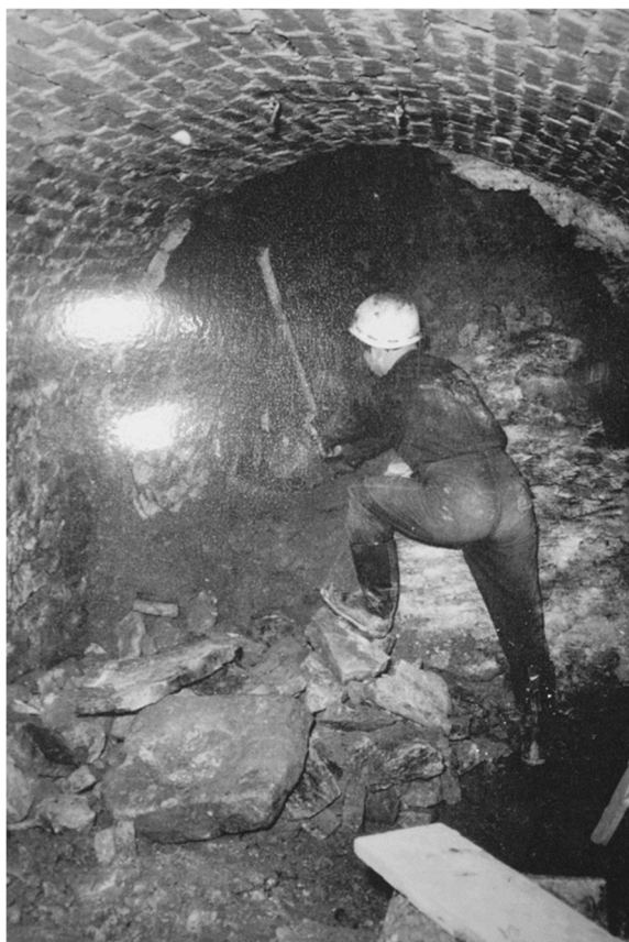
Obr. 7: Dělník při rozšiřování podzemních prostor
