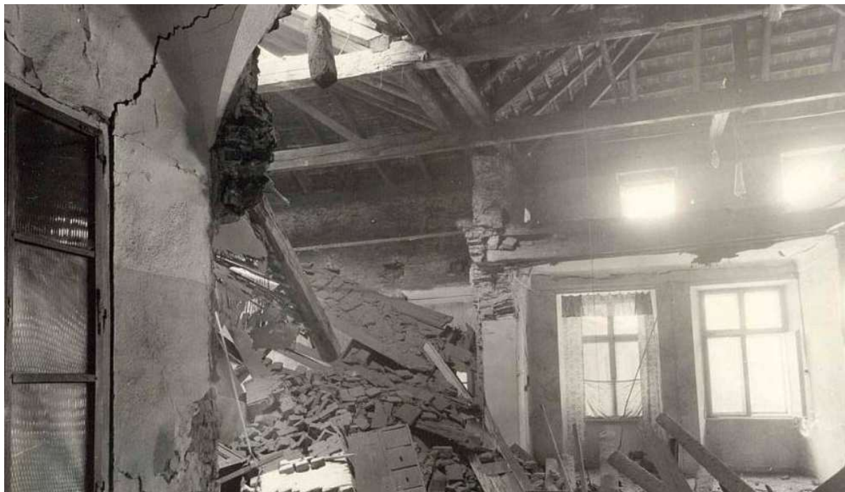
Obr. 12: Zřícený strop a poškozené zdi jednoho z domů, fotografie převzata z (Tauer 2009)
