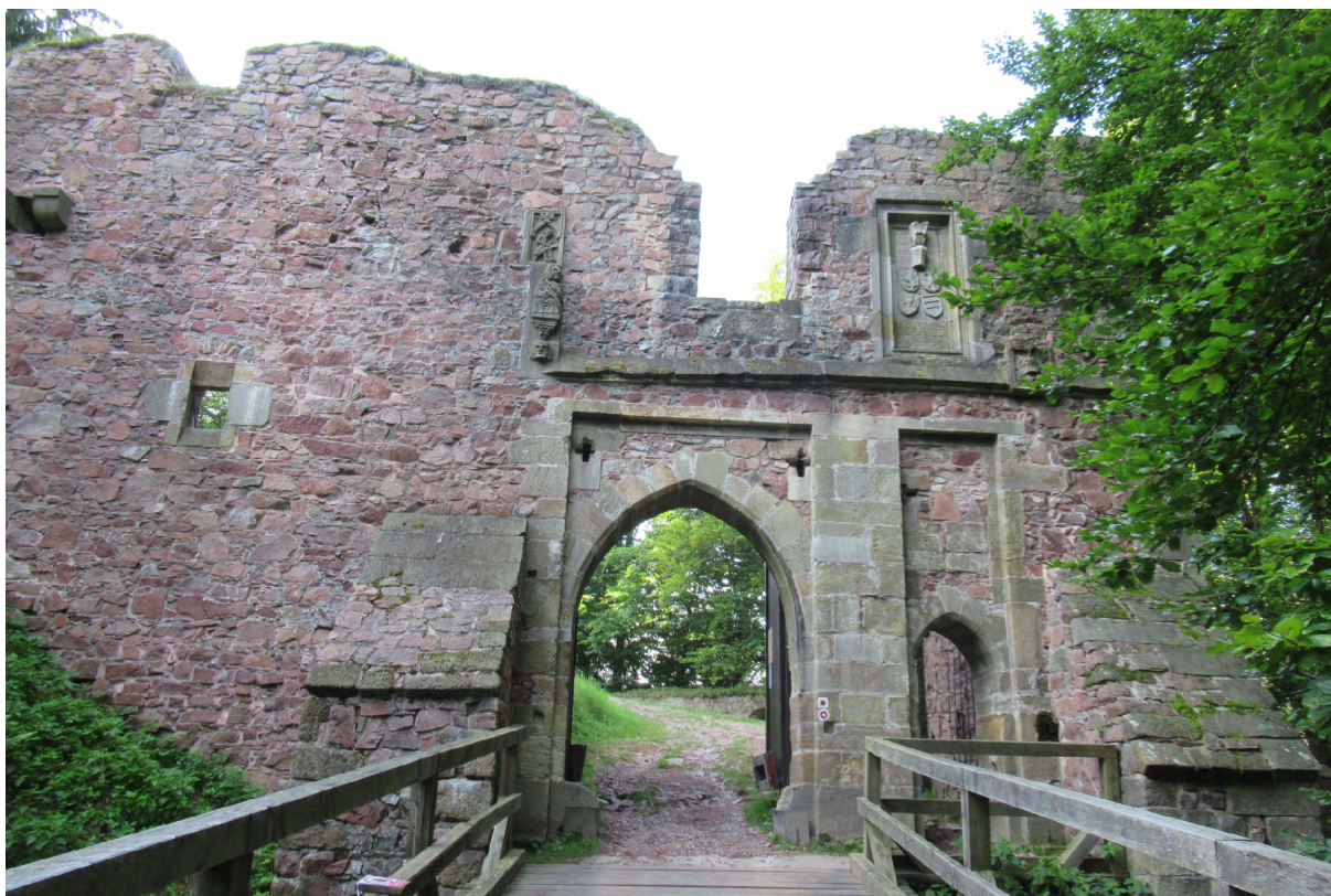
Obr. 12. Hrad Litice (okr. Ústí nad Orlicí). Vnější průčelí 1. hradní brány (foto autor, 25. 8. 2021). – Fig. 12. Litice Castle (District of Ústí nad Orlicí). The external facade of the 1st castle gate (photo by author, 25 August 2021).
