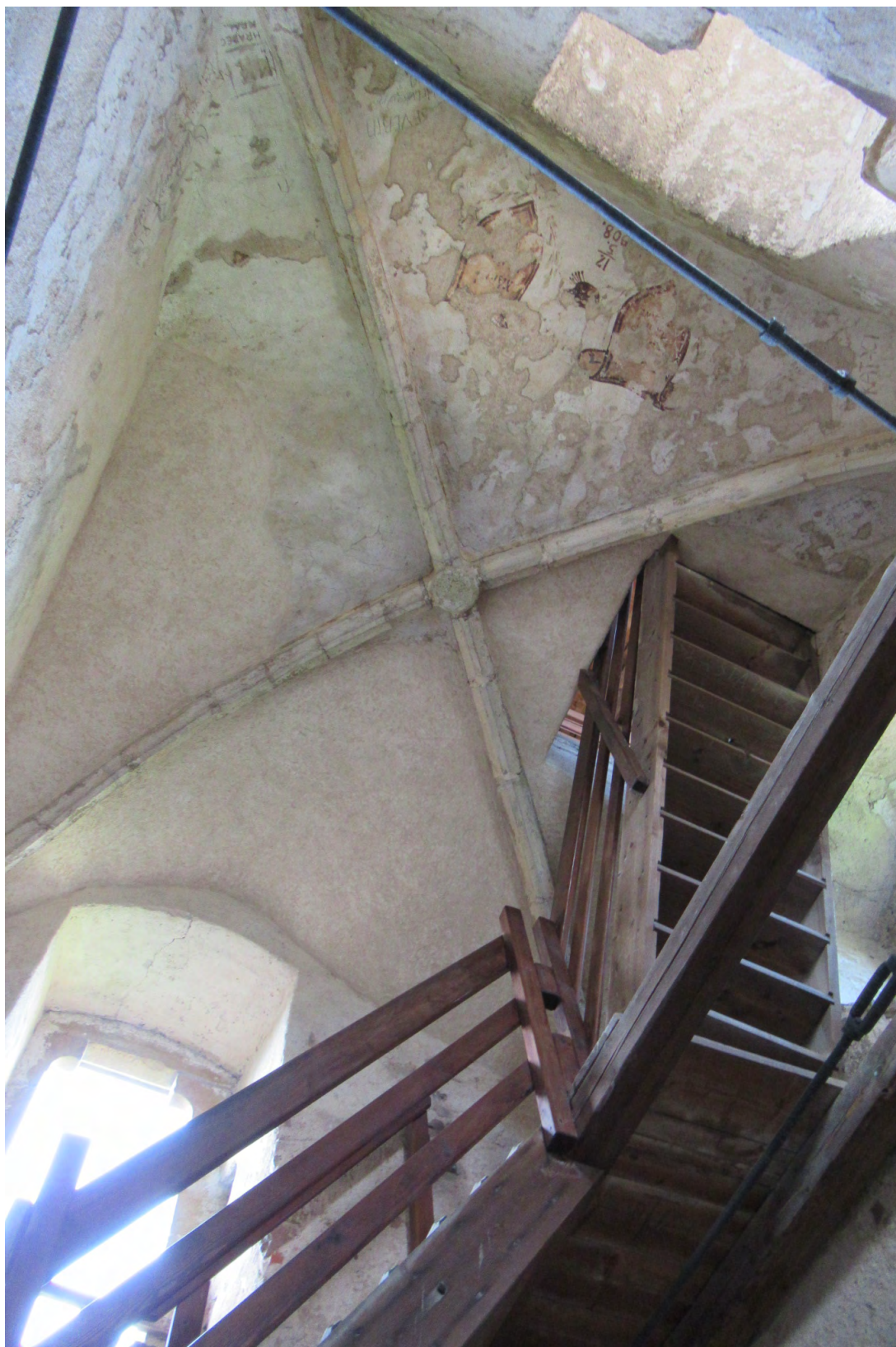
Obr. 9. Hrad Litice (okr. Ústí nad Orlicí). Interiér 2. a 3. patra věže s dřevěným schodištěm prostupujícím křížovou klenbou a železnými kleštinami (foto autor, 25. 8. 2021). – Fig. 9. Litice Castle (District of Ústí nad Orlicí). Interior of the 3rd and 4th floors of the tower with a wooden staircase penetrating a rib vault and iron tie rods (photo by author, 25 August 2021).
