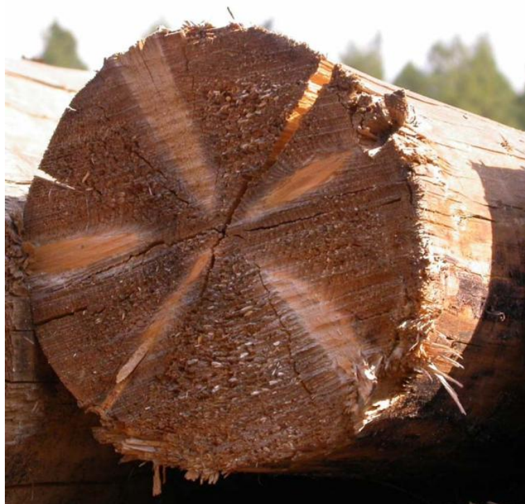
Obrázek 20 – Trhliny a suky ve dřevu (10)
