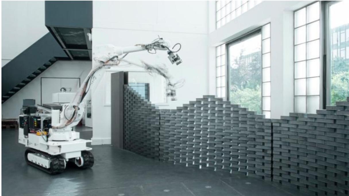
Obrázek 6: Mobilní robot In-situ Fabricator při zdění
