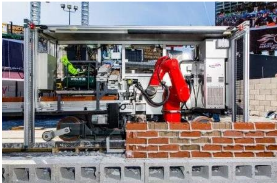
Obrázek 3: Zdící robot SAM100 společnosti Construction Robotics
