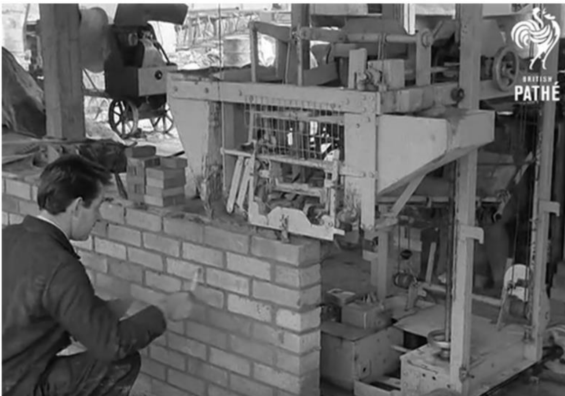
Obrázek 2: Zdící stroj „Motor Mason“ z roku 1967
