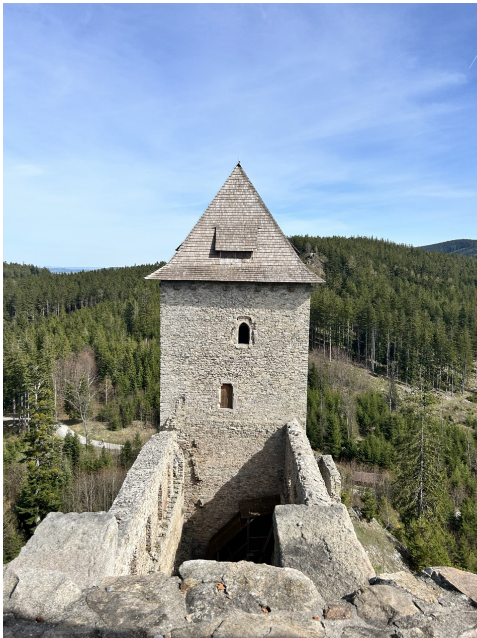
Příloha č. 13: Východní věž hradu Kašperk 83
