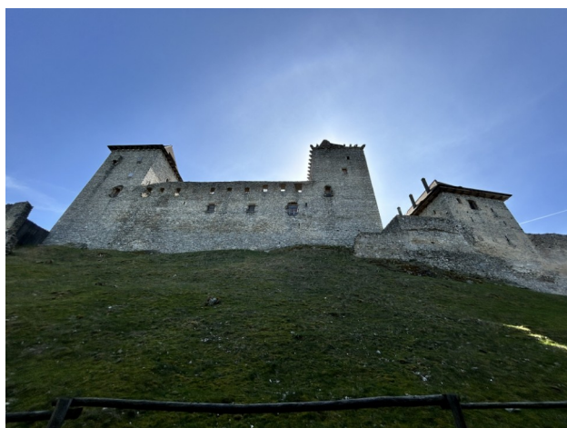
Příloha č. 9: Pohled na Kašperk z příchodové cesty 79
