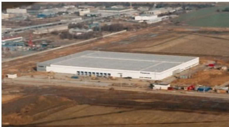
Obr. 3: Výstavba původního závodu Panasonic
