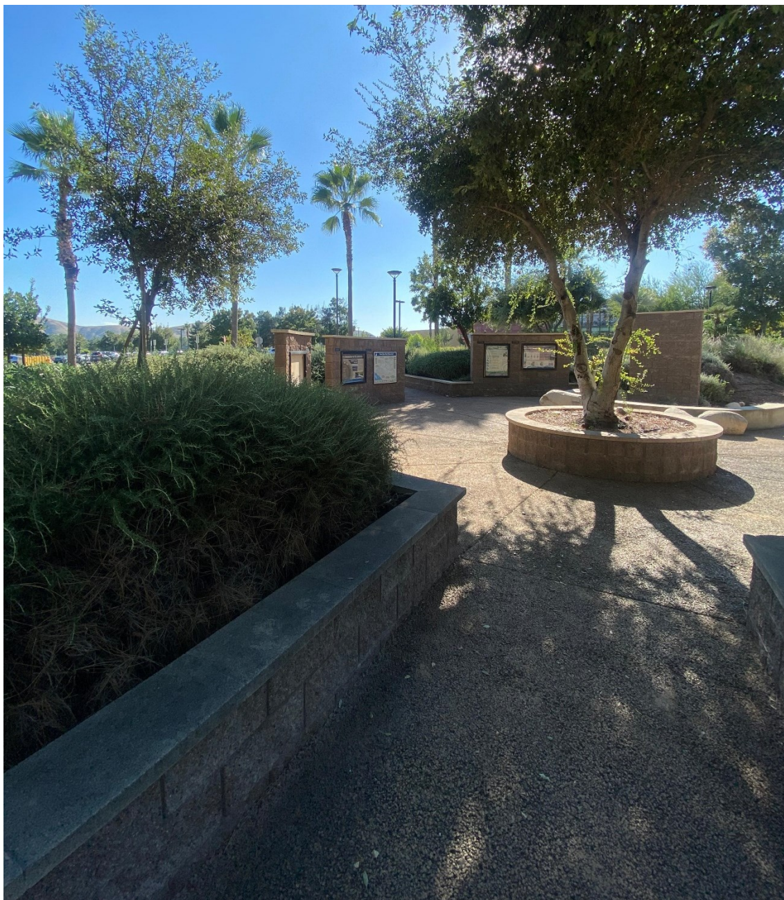
Obr. 4: parková úprava na kampusu CSUSB s drenážním betonem
