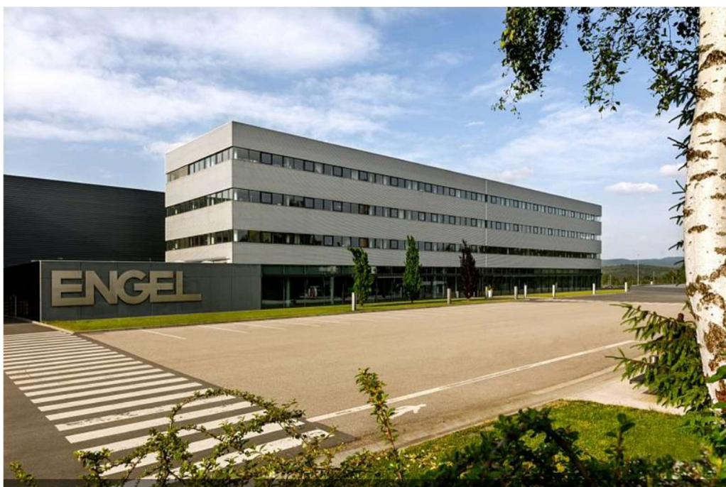
Obrázek 1 - ENGEL strojírenská spol. s r.o., závod v Kaplici [15]
