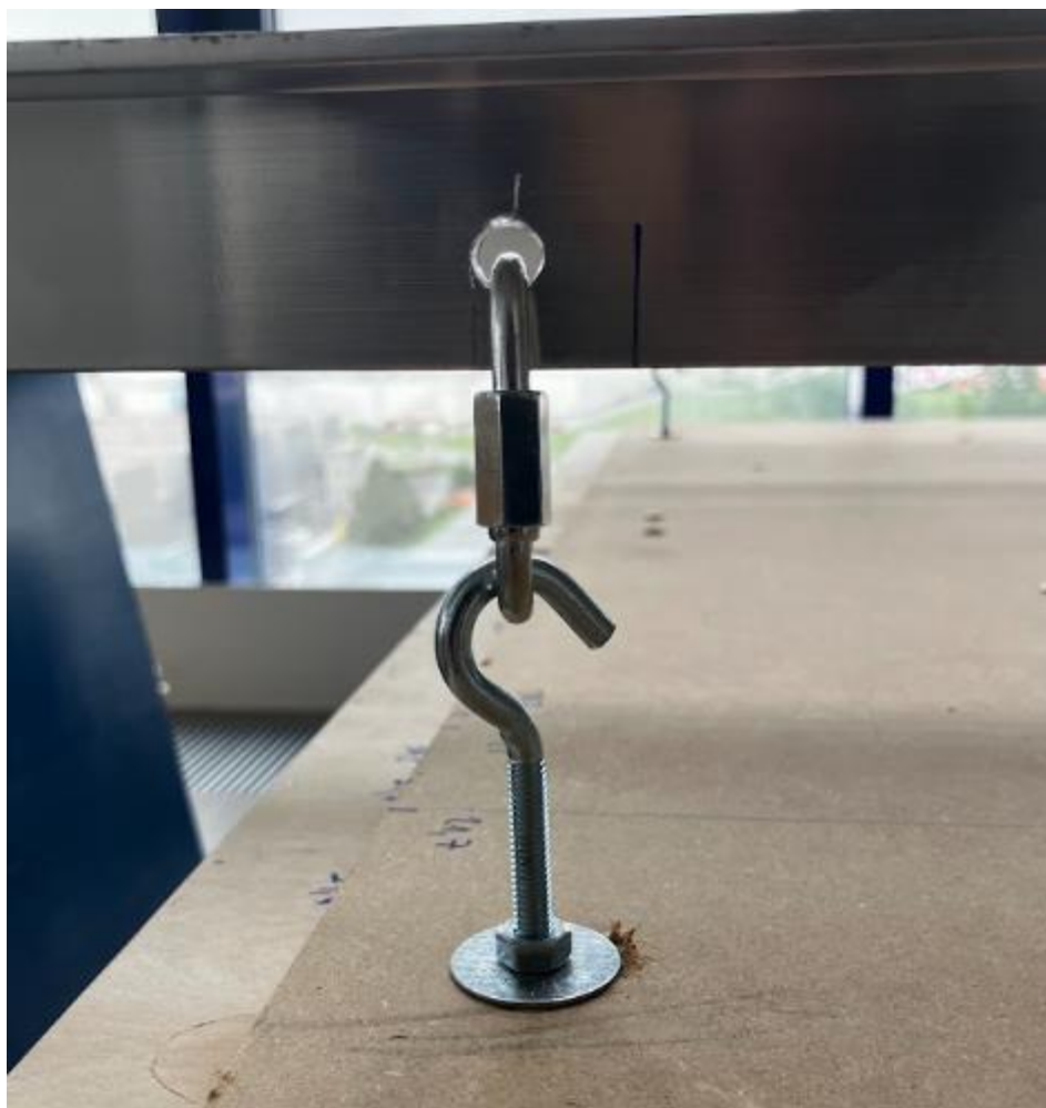
Příloha 10: Detailní fotografie uchycení akustického prvku ke hliníkovému rámu.
