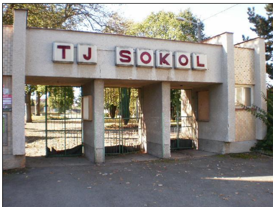
Příloha č. 28: Vstupní brána do areálu sokolovny. 228
