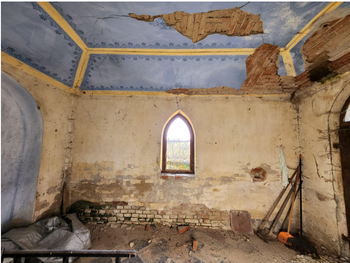
č. 9 - interiér márnice
