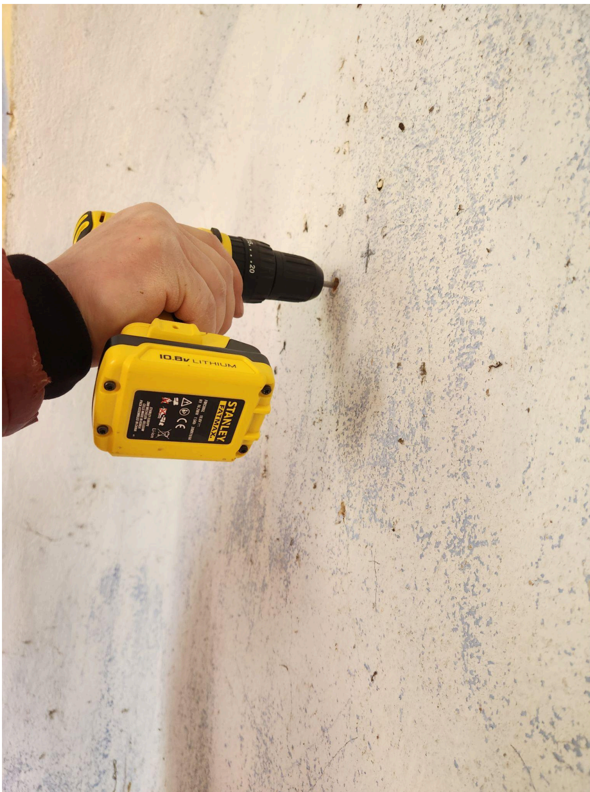
č. 22 - vrtání otvorů pro následné ukotvení závitové
