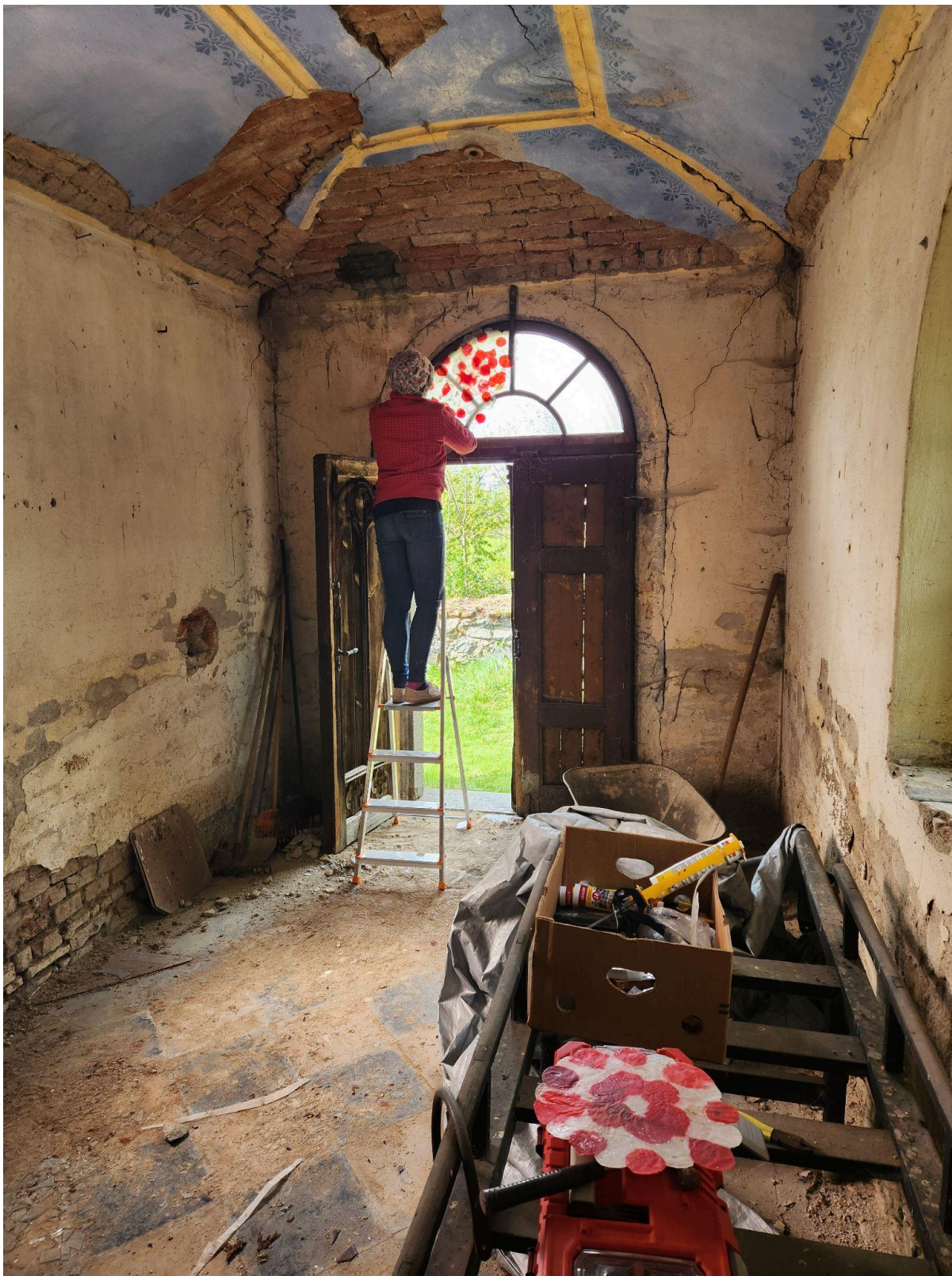
č. 20 - instalace rozety
