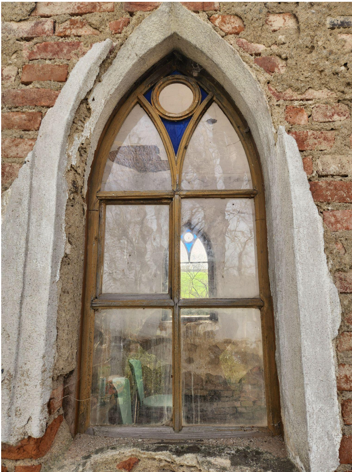
č. 12 - zachované okno, detail
