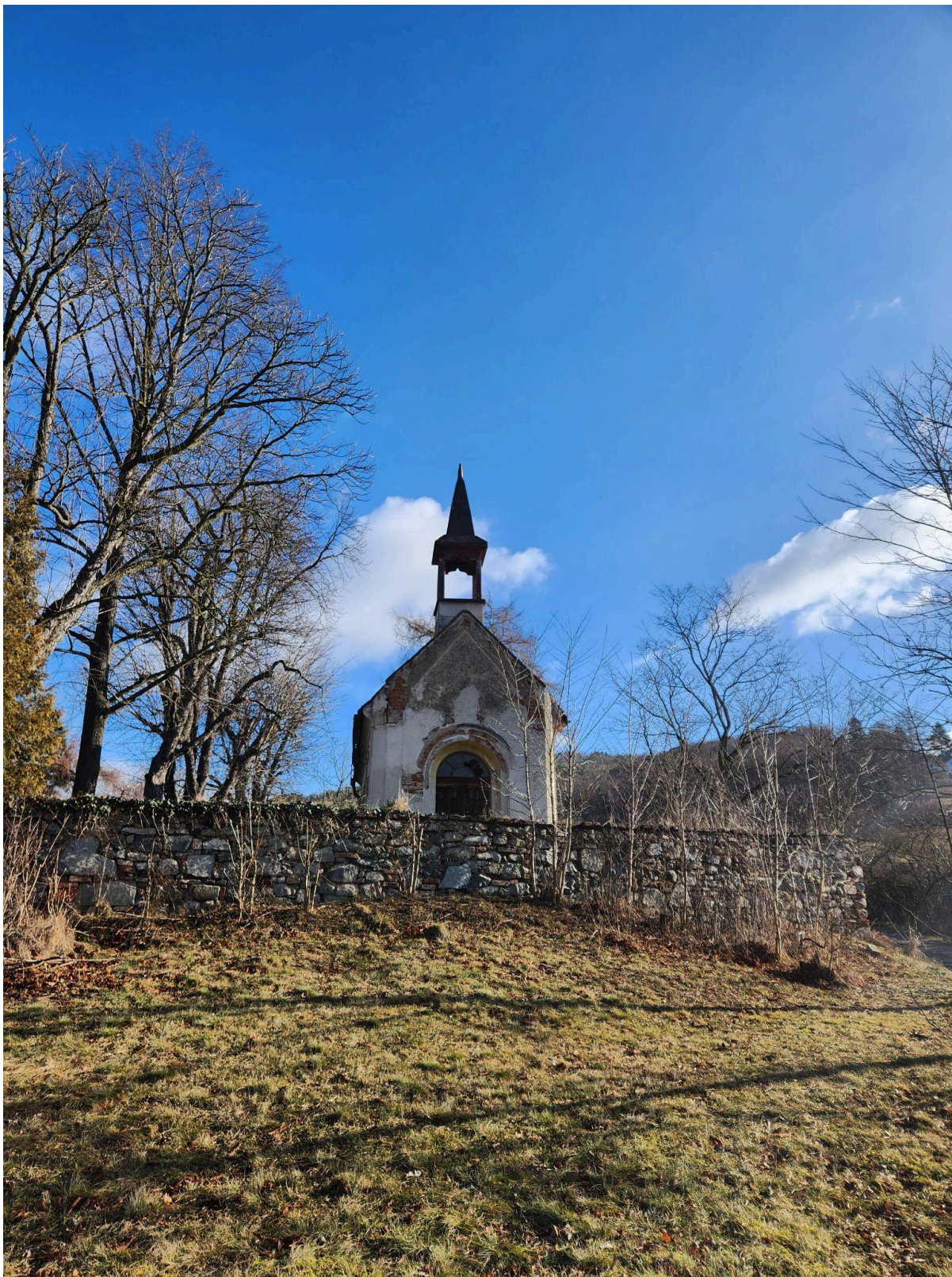
č. 6 - čelní pohled z příjezdové cesty
