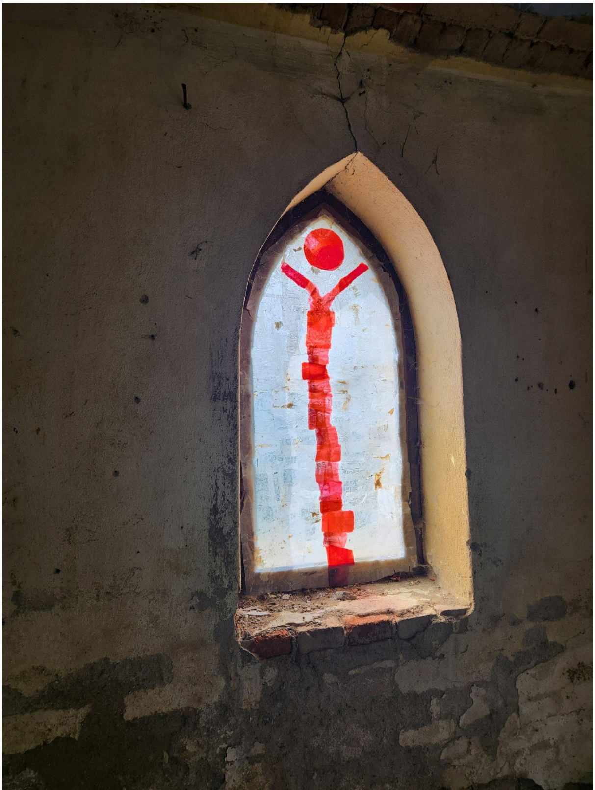
č. 21 - instalace okna
