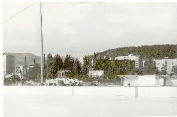
Obrázek 9 - Nezastřešený zimní stadion
